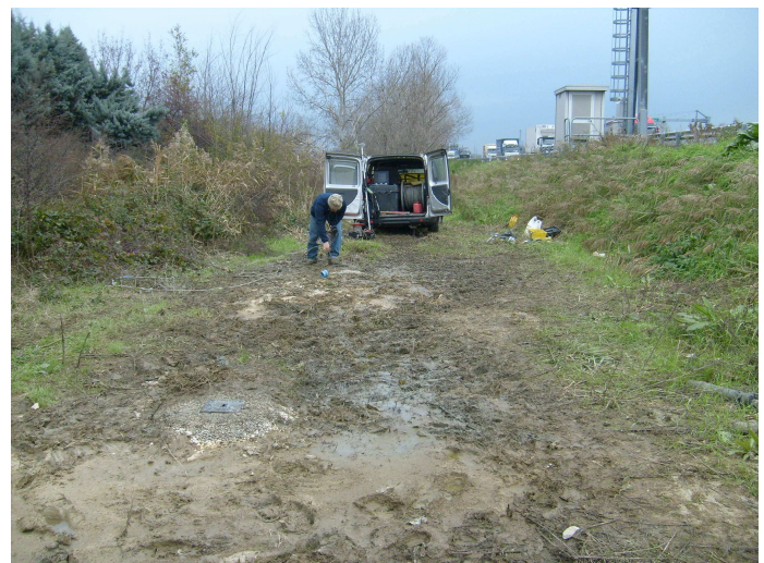
Foro OC3S2: misure di verticalità
