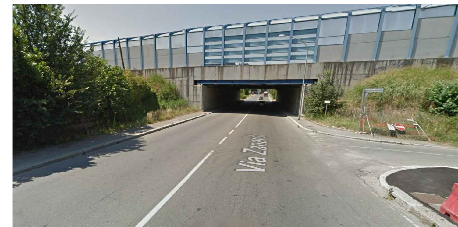
IMBOCCO SOTTOPASSO- DA SUD OVEST VERSO NORD
