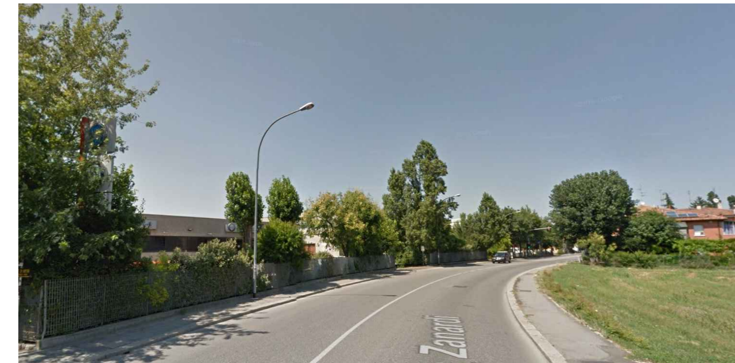
PROSEGUITO VIA ZANARDI - DIREZIONE NORD
