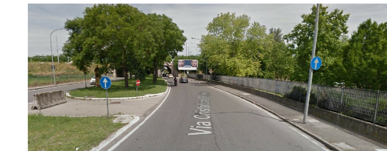
FOTO SITUAZIONE ESISTENTE IN CORRISPONDEZZA DELLA SEZIONE B-B
