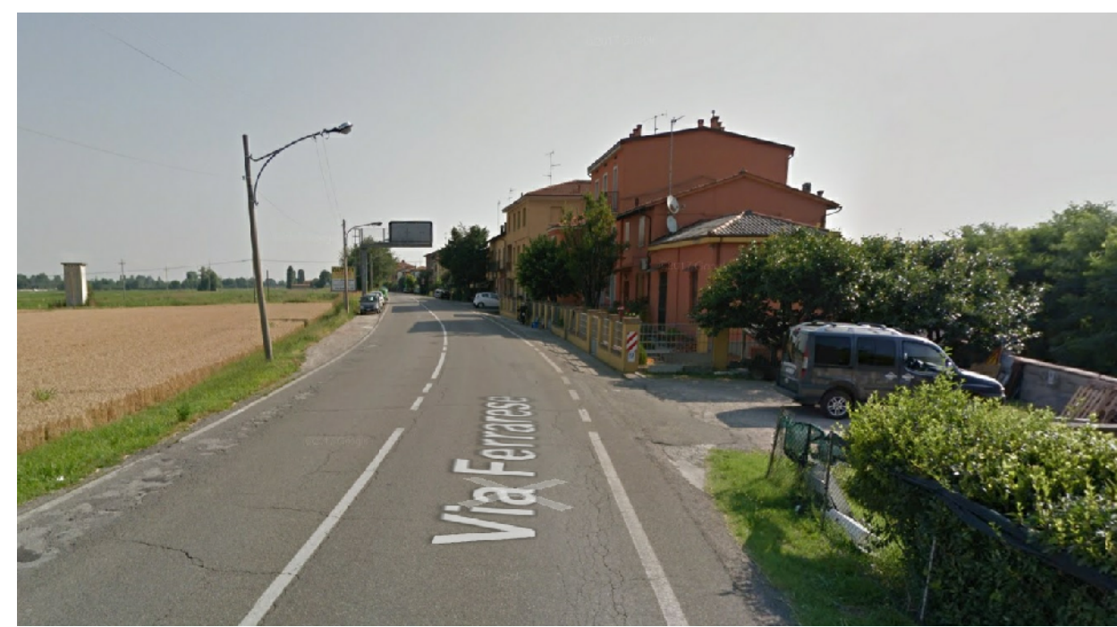
VIA FERRARESE - TRATTO TERMINALE LATO NORD - LOCALITA' CASE NUOVE
