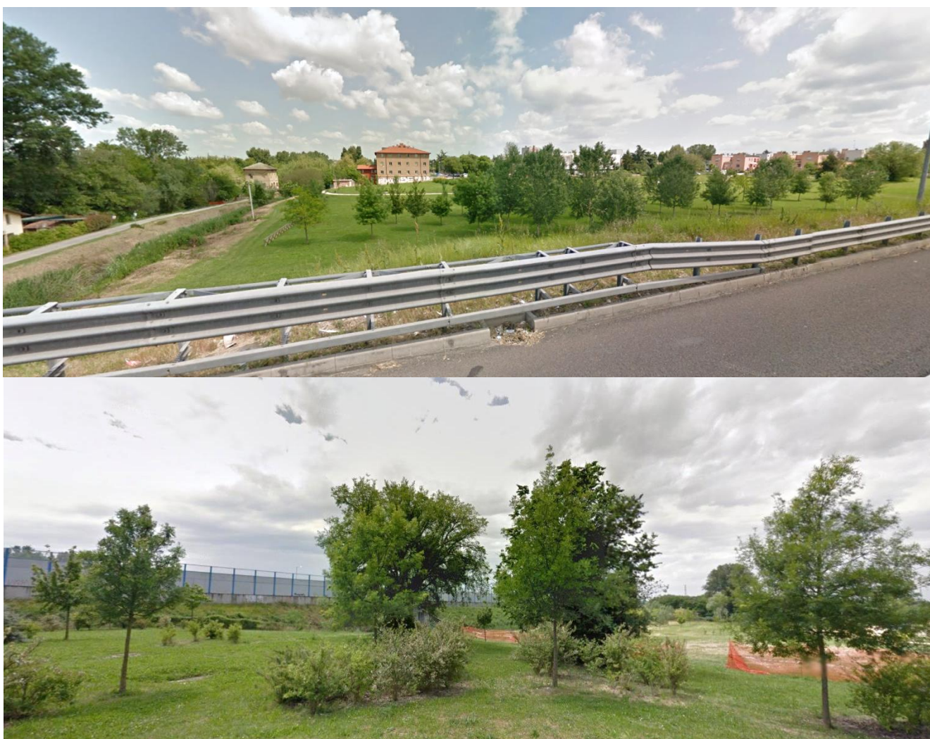
Figura 16 - due viste del Parco urbano Frisi Sostegnazzo. In alto la visuale dalla Tangenziale in direzione nord est, in cui si nota il passaggio del canale Navile
