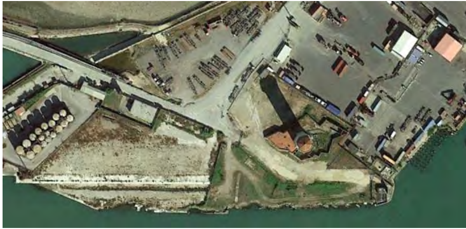
Figura 17 – Progetto acquaticità della Torre del Marzocco, situazione attuale
