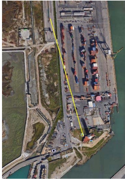
Distanza del terminal ferroviario Darsena Toscana dall'area di cantiere
