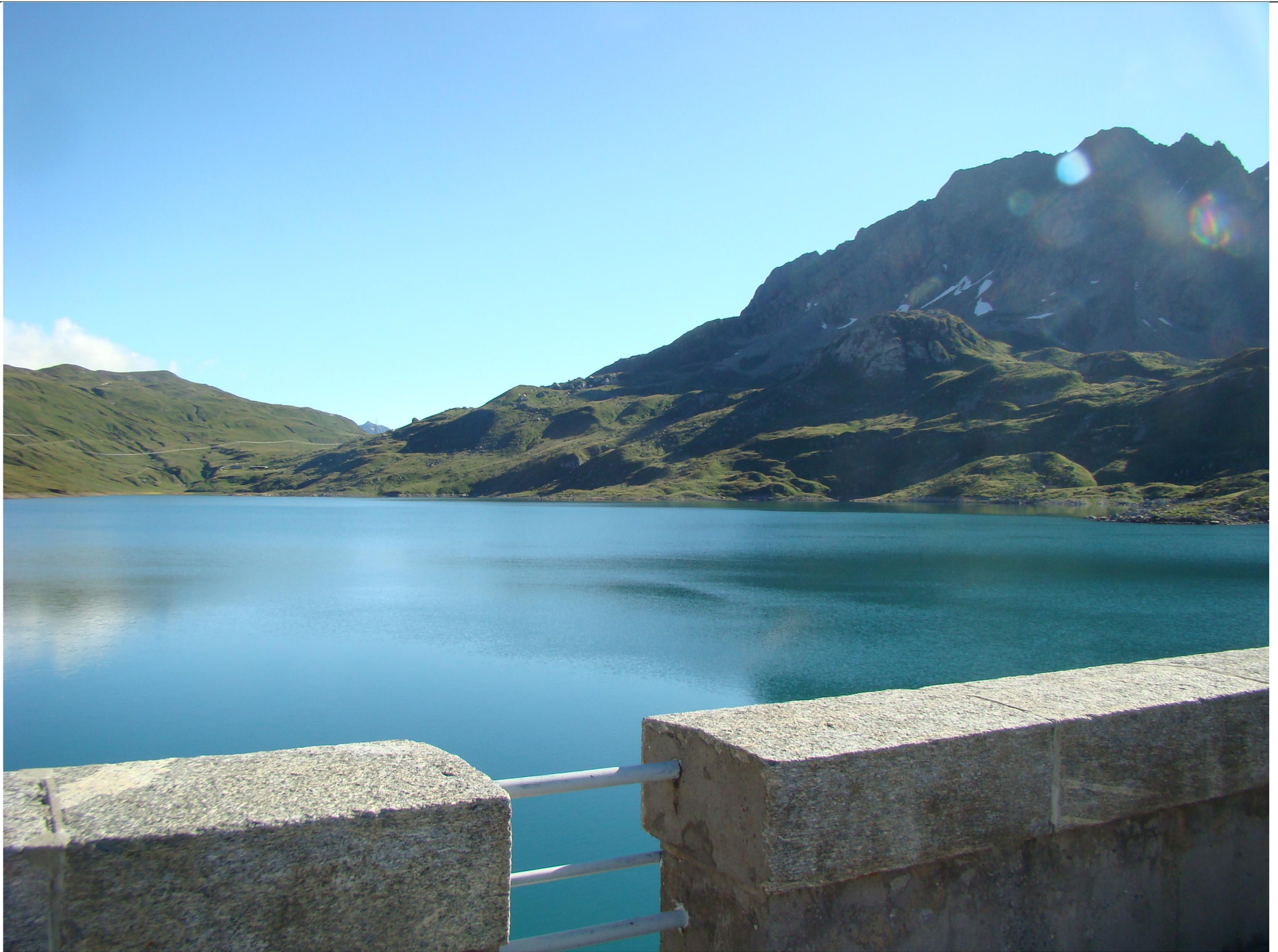
PUNTO VISUALE PV.2 - ANTE OPERAM - STATO DI FATTO
