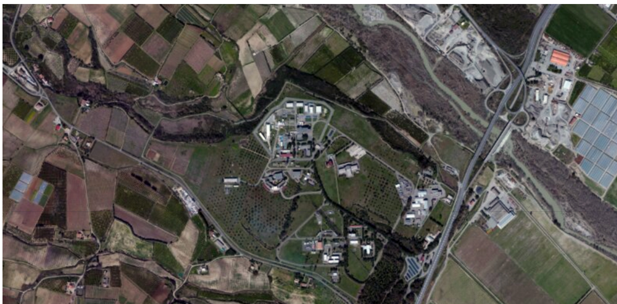
Figura 2.1-8: Impianto ITREC - Rotondella
