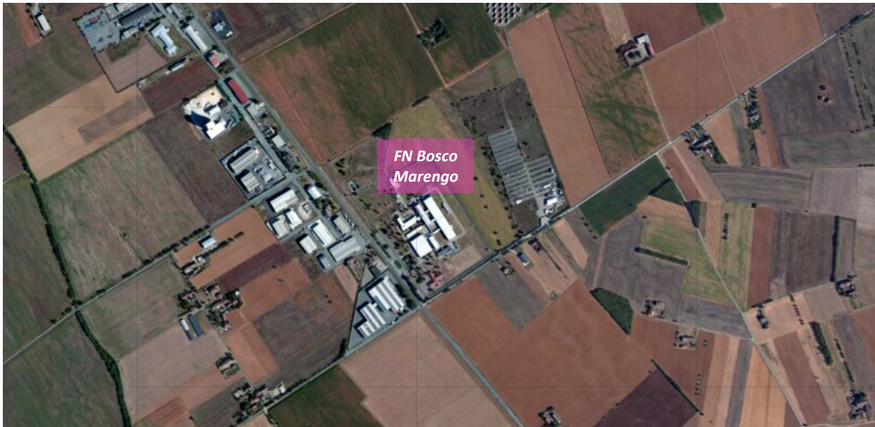
Figura 2.1-5: Impianto FN di Bosco Marengo
