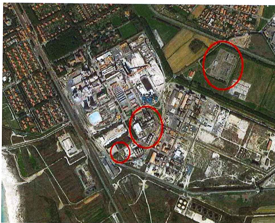
Figura 3 – Localizzazione di dettaglio dell'area di progetto all'interno dell'area di Solvay su foto aerea
