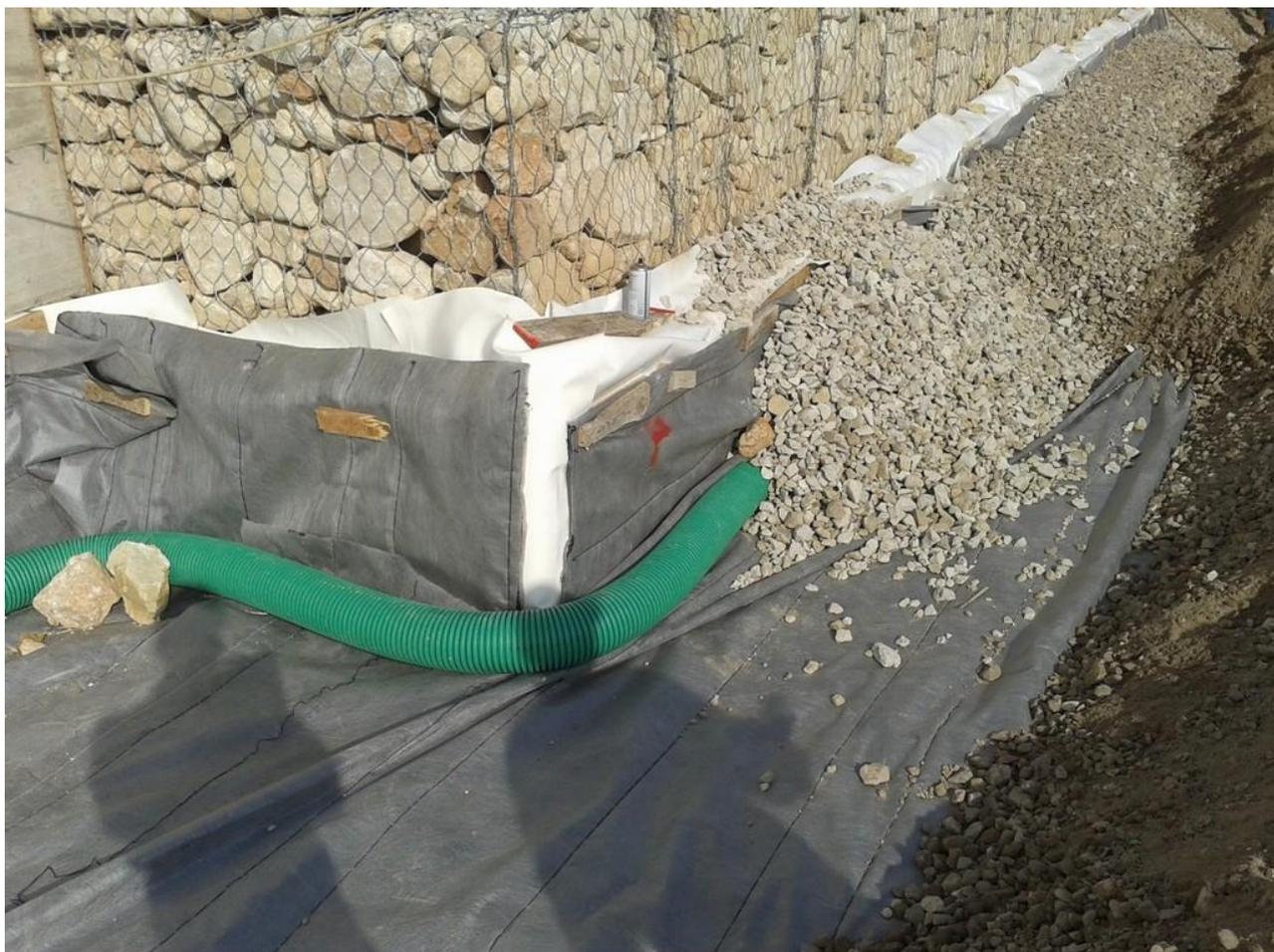
Figura 4 – particolare fase impermeabilizzazione del piazzale
