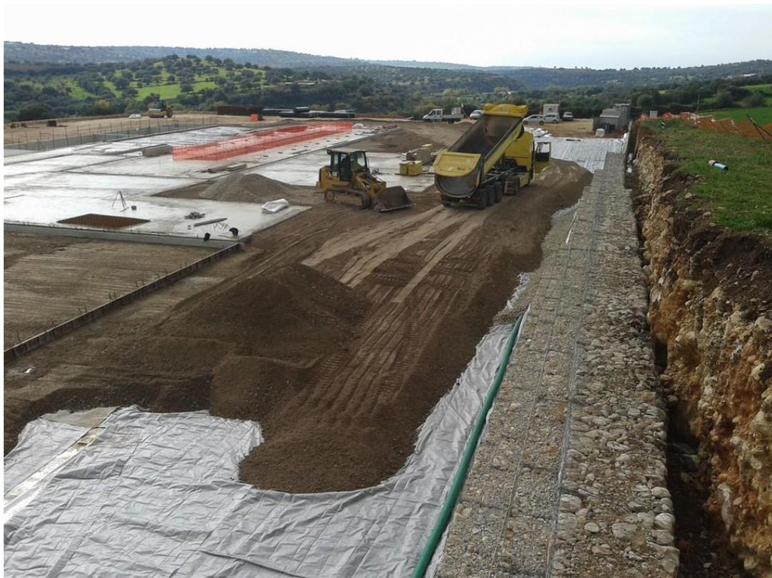
**Figura 2 – fase impermeabilizzazione del piazzale**
