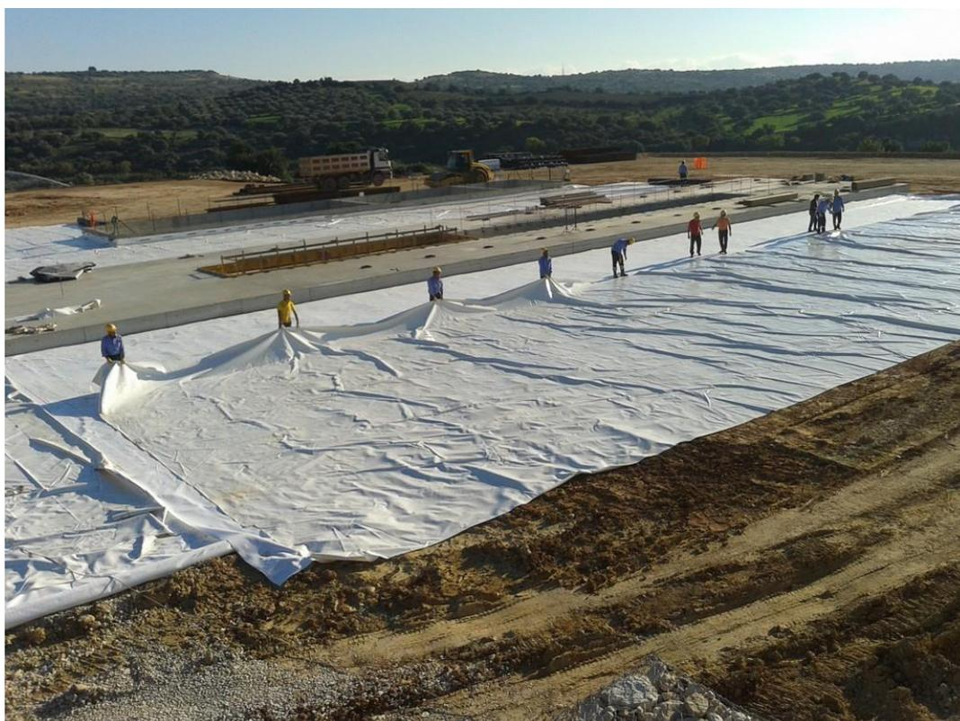
**Figura 3 - fase impermeabilizzazione del piazzale**
