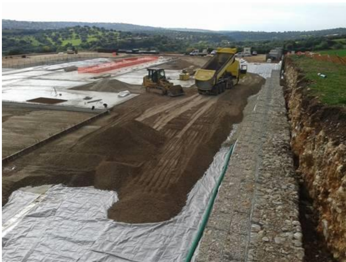
Figura 2 – esempio di opere di impermeabilizzazione del piazzale di perforazione
