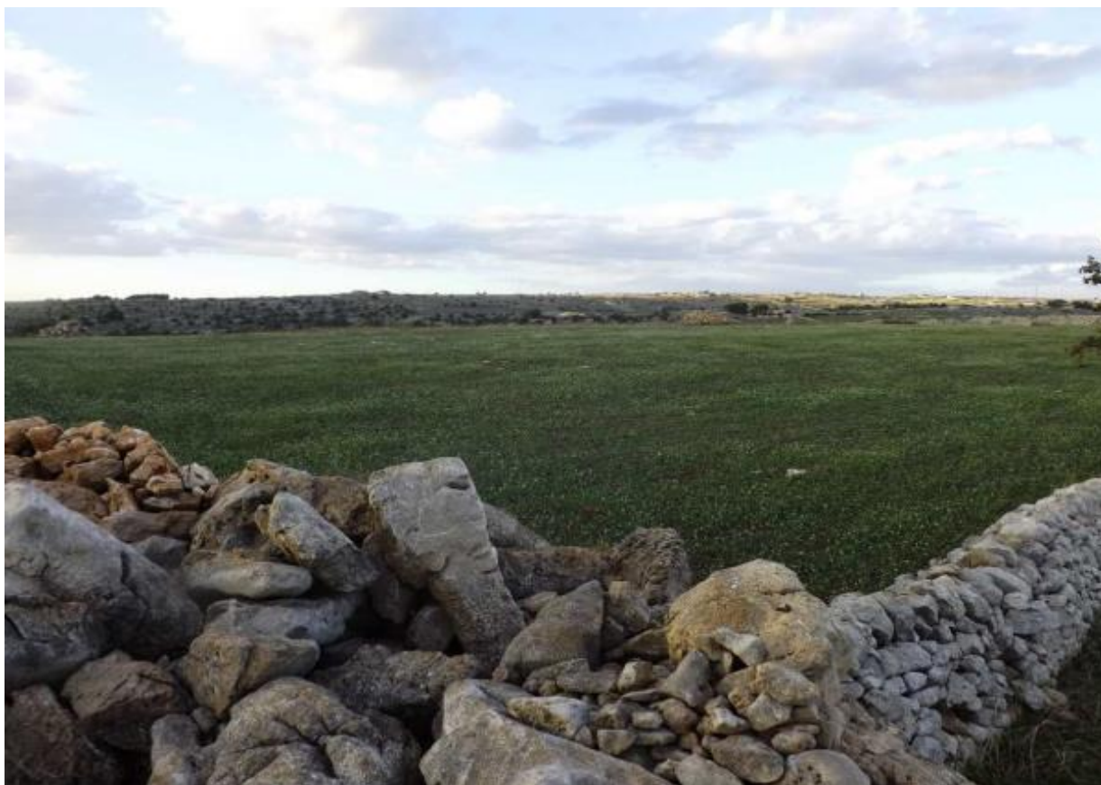
Figura 8 - muretti a secco presenti nell'area di progetto prevista per la realizzazione della strada di accesso
