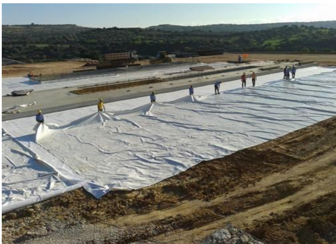
Figura 3 - esempio di opere di impermeabilizzazione del piazzale di perforazione
