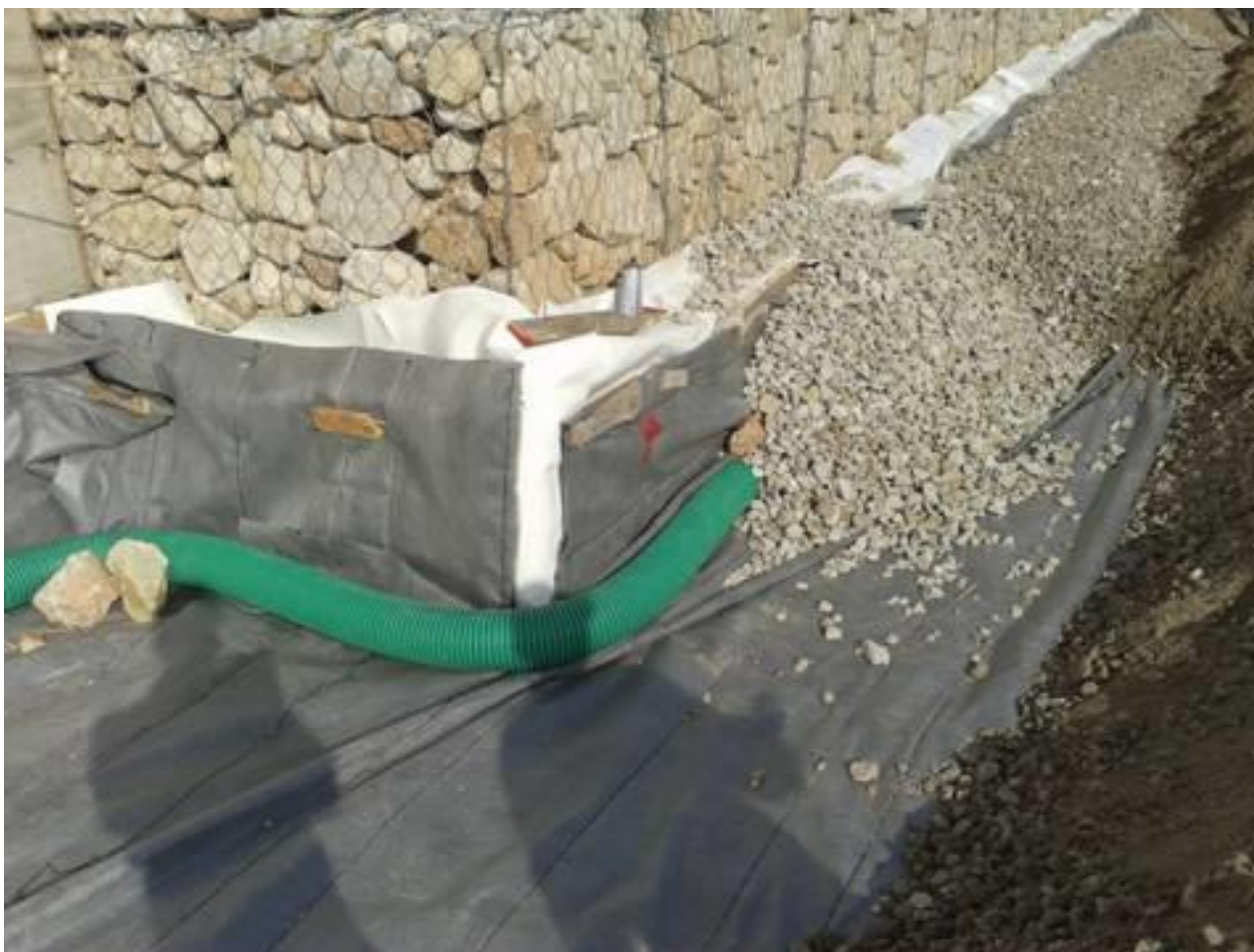
Figura 4 - esempio di opere di impermeabilizzazione del piazzale di perforazione
