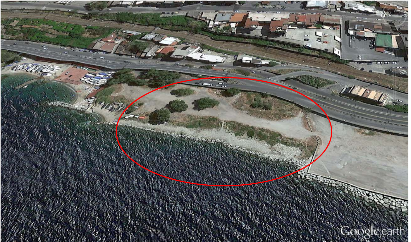
Figura 15 - Vista dal mare da Google earth
