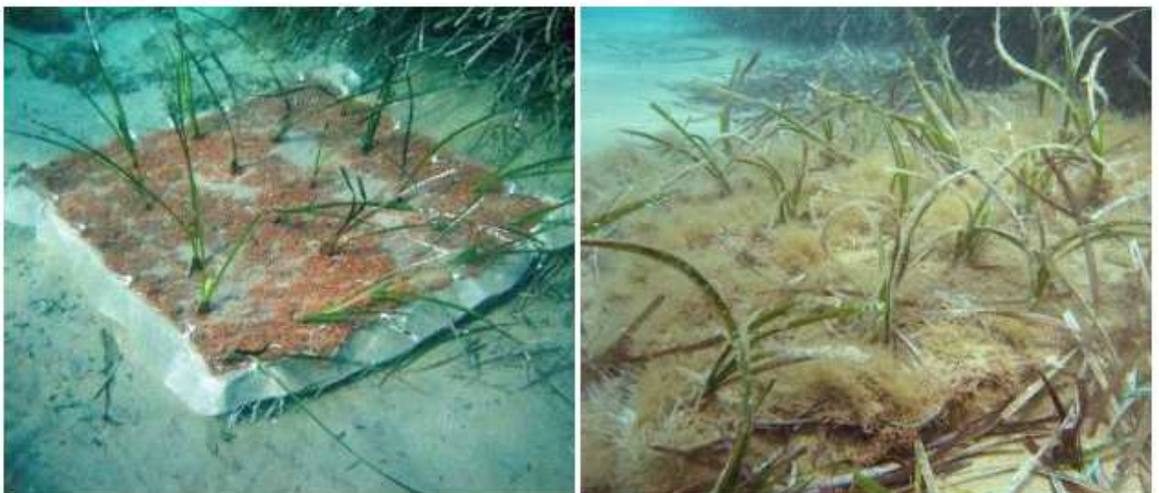
Figura 1 Posa in opera del materasso sul fondale – e Materasso rinverdito su fondale dopo 7 mesi
