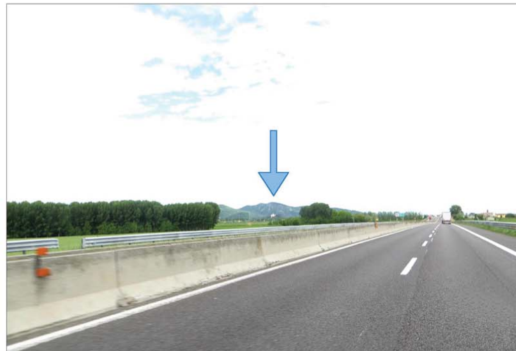
07. Ripresa in direzione Nord dalla A13. Sullo sfondo, in direzione nord ovest villa Emo Selvatico a Battaglia Terme. Sulla carreggiata di destra è previsto l'inserimento di una barriera antirumore.
