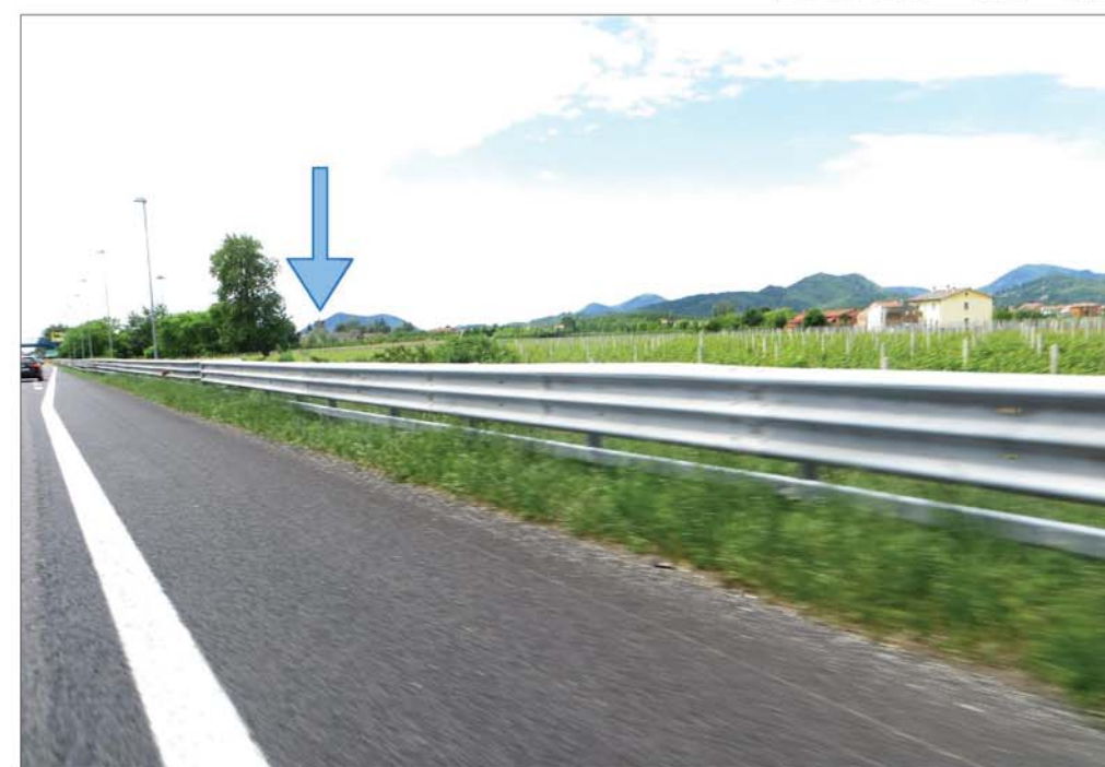
16. Ripresa del Castello di San Pelagio dalla A13, direzione Bologna. Sullo sfondo l'ingresso all'area di servizio San Pelagio Est.
