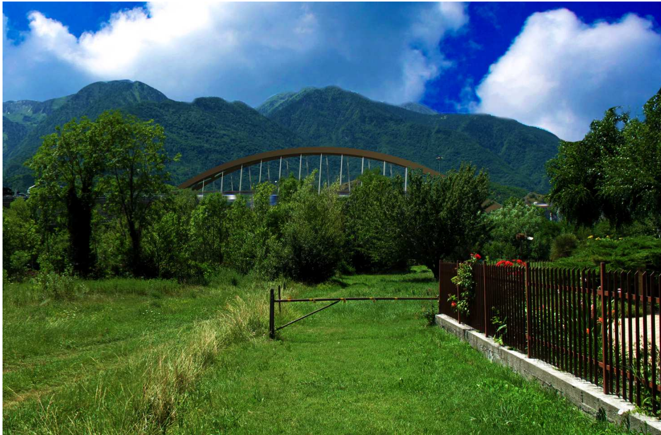
PHOTOMONTAGE DU PONT SUR LA DORA A SUSE - FOTOMONTAGGIO PONTE DORA A SUSÀ
