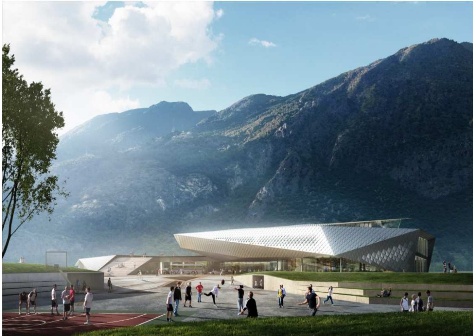
GARE INTERNATIONAL DE SUSE – STAZIONE INTERNAZIONALE DI SUSA
