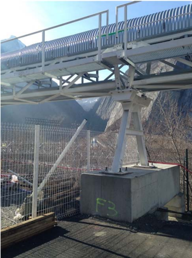
FIGURA 20 - SISTEMA DI NASTRI TRASPORTATORI POSTI IN OPERA SUL VERSANTE FRANCESE
