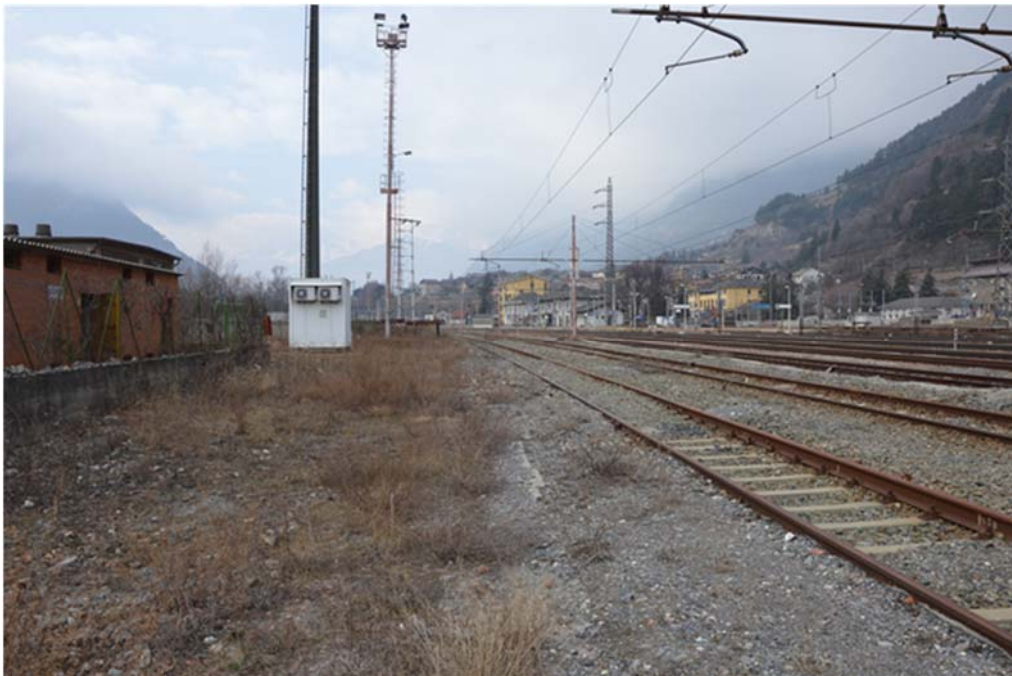
FIGURA 24 - VISTA DAL PIANO DI CARICO DELLA STAZIONE DI SALBERTRAND
