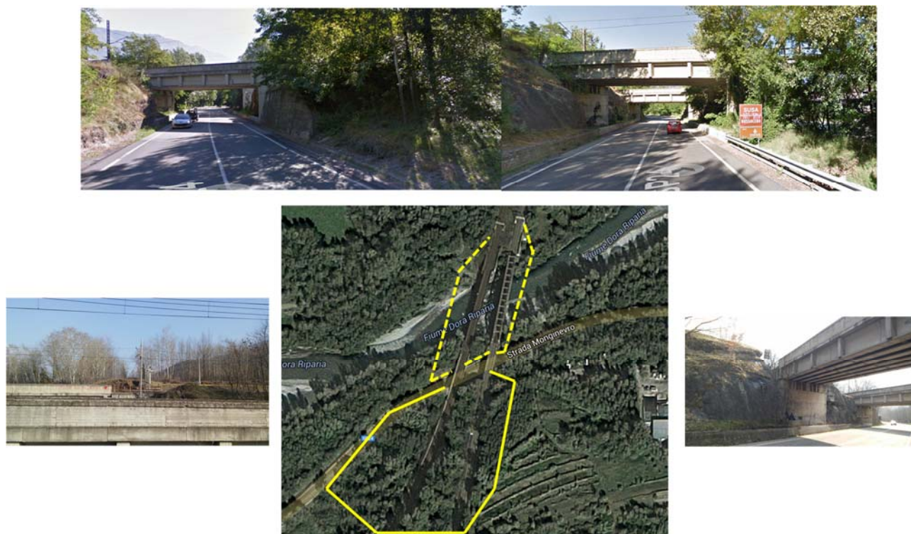
FIGURA 15 - AREA DEL CANTIERE ALL'IMBOCCO EST DEL TUNNEL DI INTERCONNESSIONE
