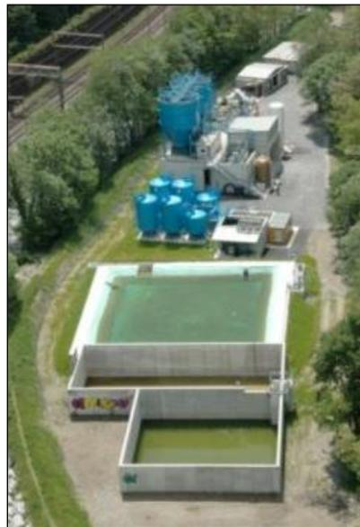
*Figura 1 – Cantiere AlpTransit (Vigana) – Impianto di trattamento delle acque reflue di cantiere*
