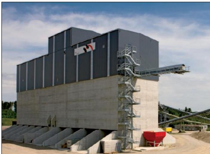
*Figura 6 – Impianto di valorizzazione dei materiali di scavo – Particolare della tipologia di schermatura contro rumore e polveri*
