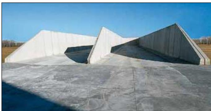
**Figura 13** – Silos orizzontale con elementi prefabbricati in calcestruzzo modulabili (da utilizzarsi all'interno di aree coperte)
