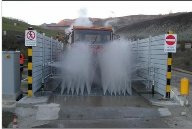
*Figura 9 – Impianto di lavaggio degli autoveicoli e degli automezzi*
