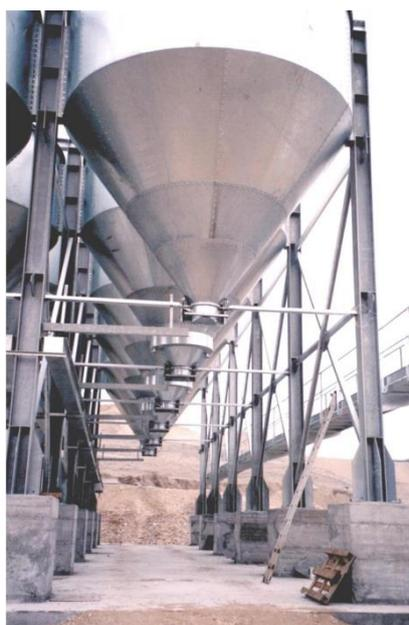
*Figura 15 – Silos stoccaggio inerte con bocchette di scarico per carico diretto su camion*
