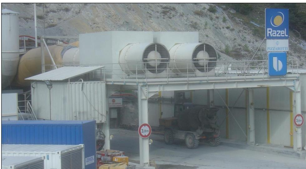
*Figura 8 – Impianto di ventilazione – Particolare dei silenziatori e carter di insonorizzazione dei motori*
