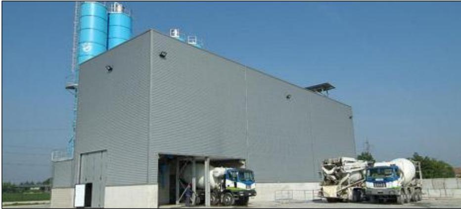
*Figura 2 – Impianto di betonaggio – Particolare della tipologia di schermatura contro rumore e polveri*
