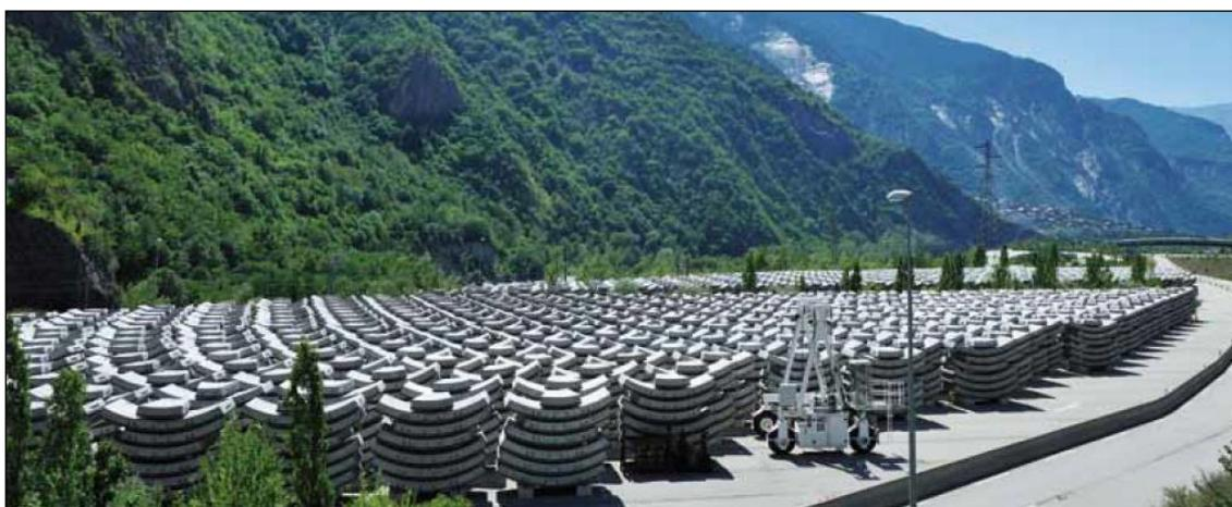
*Figura 5 – Stoccaggio dei conci prefabbricati per il cantiere della Galleria di Sicurezza del Frejus (presso St. Etienne de Cuines) – Movimentazione con carro-ponte su gomma*
