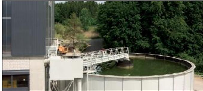
*Figura 7 – Impianto di valorizzazione dei materiali di scavo – Particolare dell'impianto di trattamento delle acque*
