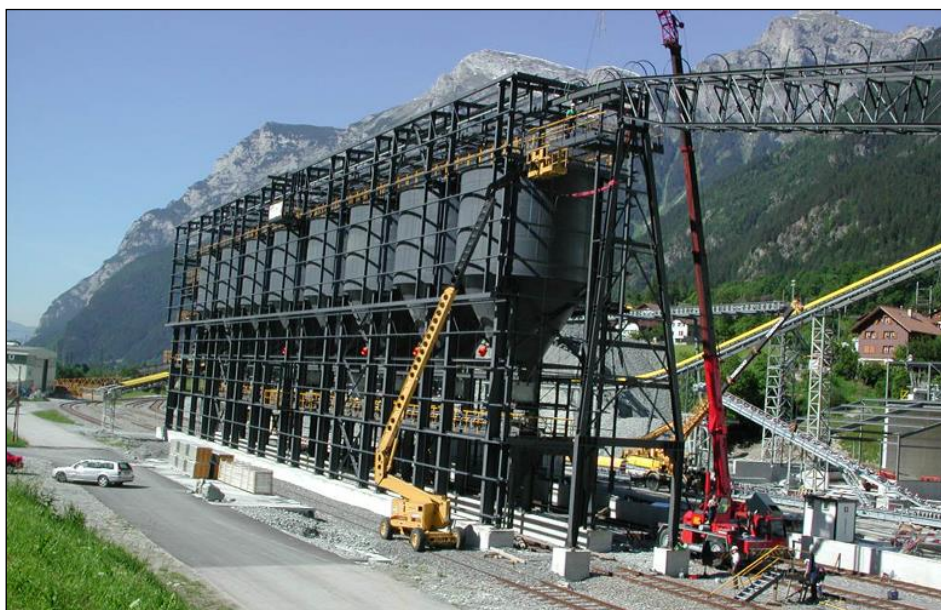
Figura 3 – Cantiere AlpTransit (Amsteg) – Impianto di caricamento su treno in corso di costruzione (a fine lavori l'impianto sarà completamente chiuso, vedere Figura 2) si noti anche la movimentazione dei materiali mediante nastri trasportatori chiusi
