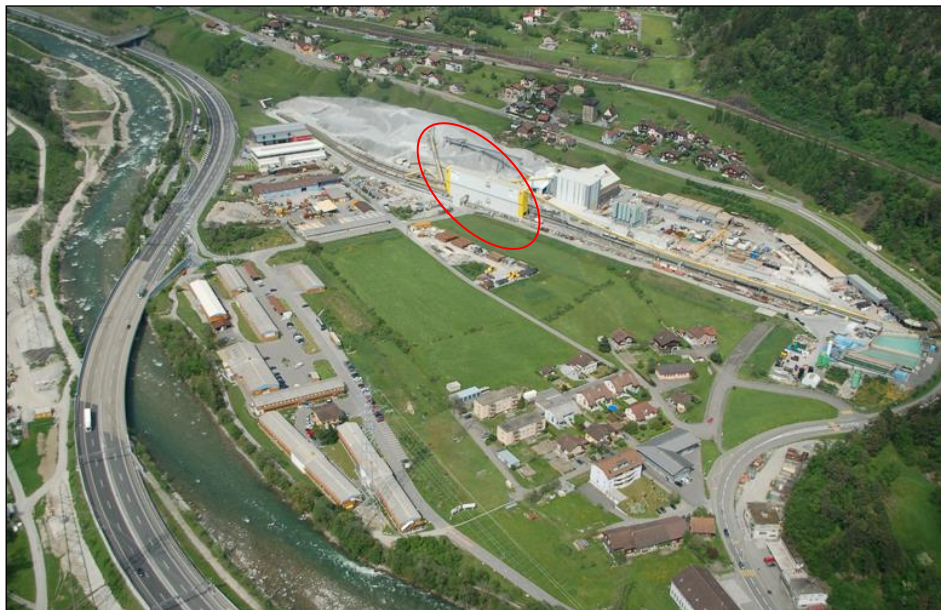
Figura 2 – Cantiere AlpTransit (Amsteg) – Vista generale del cantiere e (cerchiato in rosso) l'impianto di caricamento su treno completamente chiuso.
