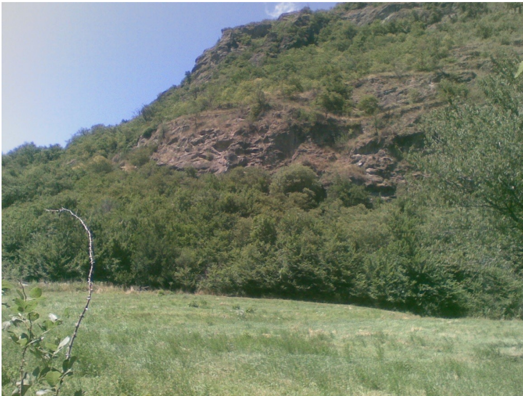
Figura 5 – Parete dell'imbocco: al piede dell'affioramento roccioso si osservano i detriti di falda, coperti da vegetazione arborea e arbustiva in evoluzione, e terrazzati artificialmente.
