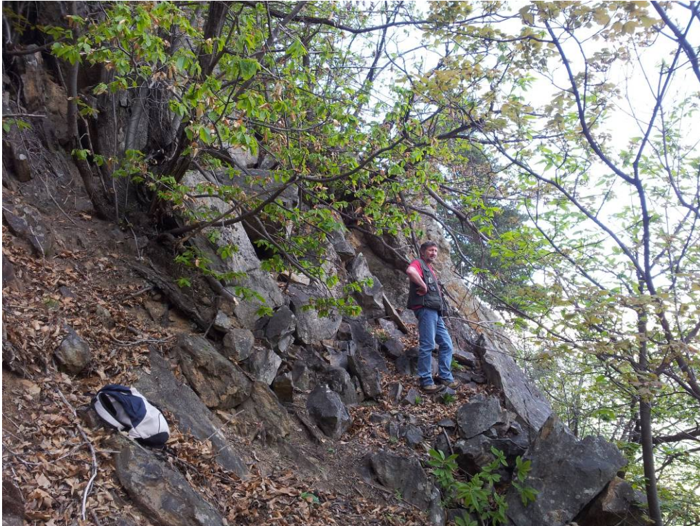
Fig. 34 –Porzione di substrato disarticolato con massi instabili, da monitorare attraverso clinometri, fessurimetri e misuratori di giunti.
