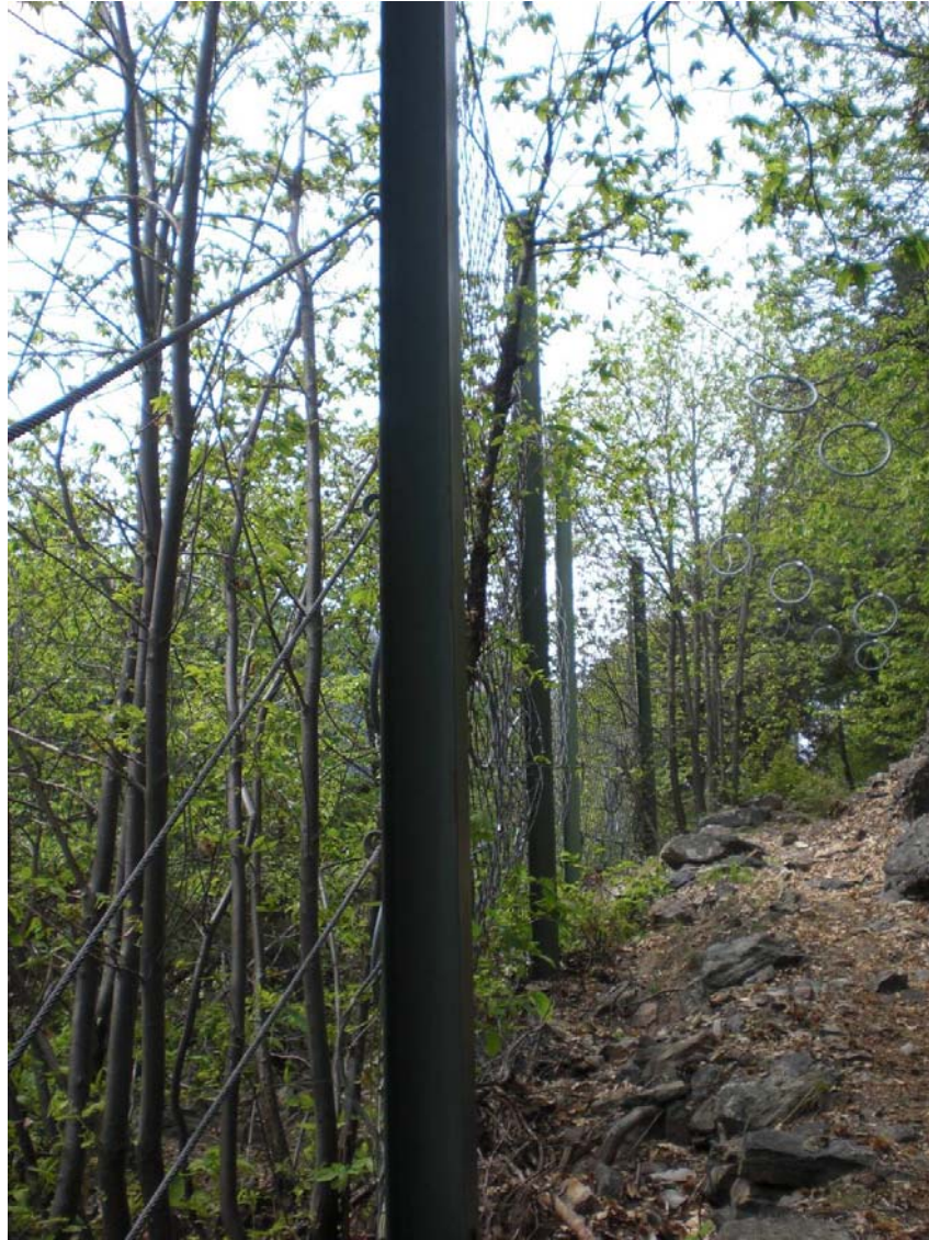
Fig. 35 – Dettaglio delle barriere paramassi esistenti presenti lungo il versante.
