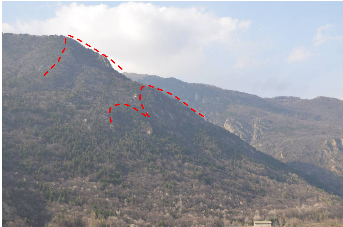
Fig. 2 – Dettaglio del versante in frana. In rosso il coronamento schematico della nicchia principale e di quella secondaria (punto di ripresa: Chiomonte, loc. Custunet)
