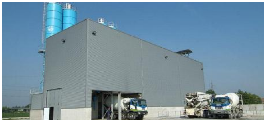
Impianto di betonaggio – Particolare della tipologia di schermatura contro rumore e polveri
