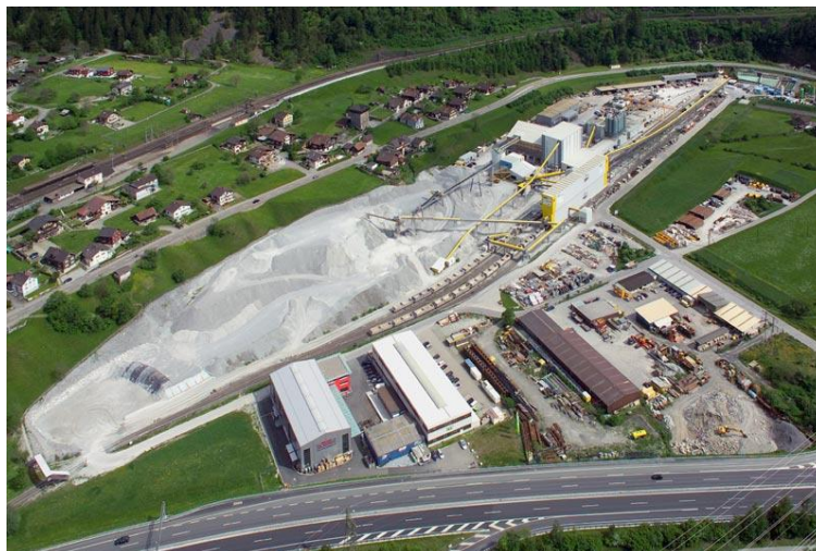
Impianto di caricamento con tramogge distribuite lungo l'intero fascio binari (esempio)
