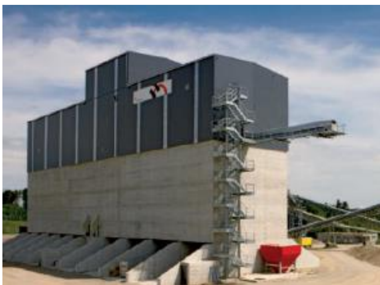
Impianto di valorizzazione inerti Particolare della tipologia di schermatura contro rumore e polveri
