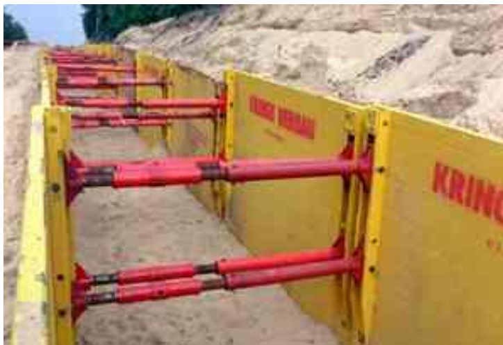
Esempio sistema di casseratura di protezione
