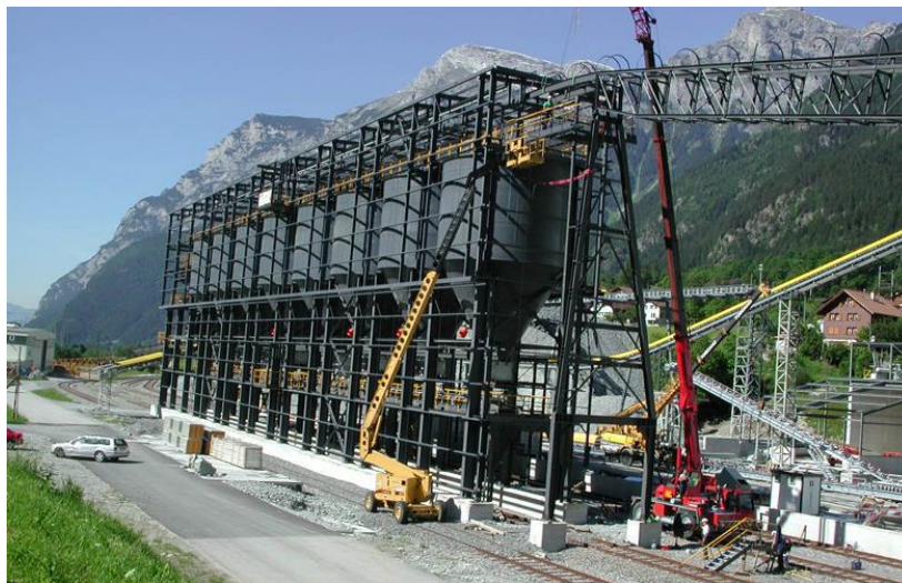
Esempio di tramoggia di scarico degli aggregati
