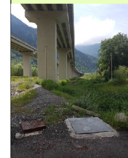
04. Viadotto autostrada A32
