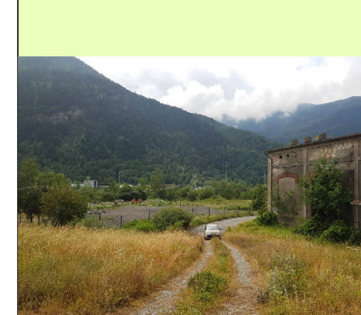
01. Interno del cantiere - Edifici lato ovest
