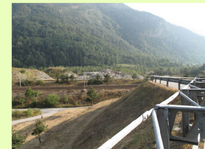
06. Vista da area imbocco ovest della galleria di Serre la Voute
