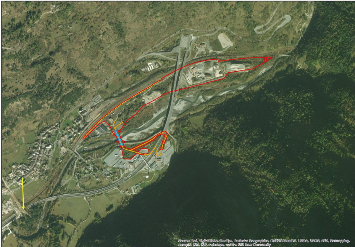
Figura 29 – Localizzazione del sovrappasso esistente sulla A32, in località loc. Chenebrieres
