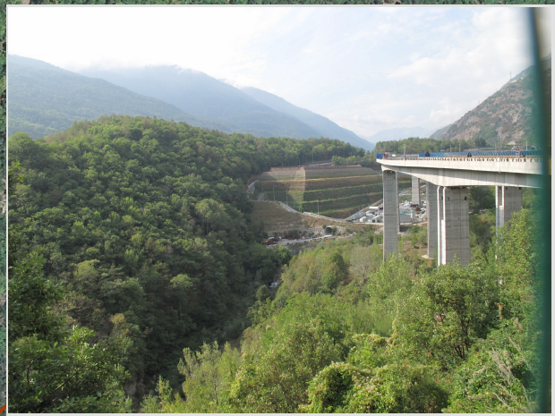
12 - Vista da S. Lorenzo - Ingresso est cantiere
