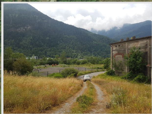
1 - Interno del cantiere - Edifici lato ovest
