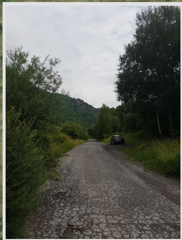
2 - Strada interna lato nord
