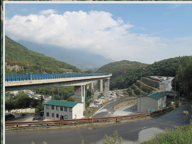
9 - Maddalena da ingresso ovest cantiere
