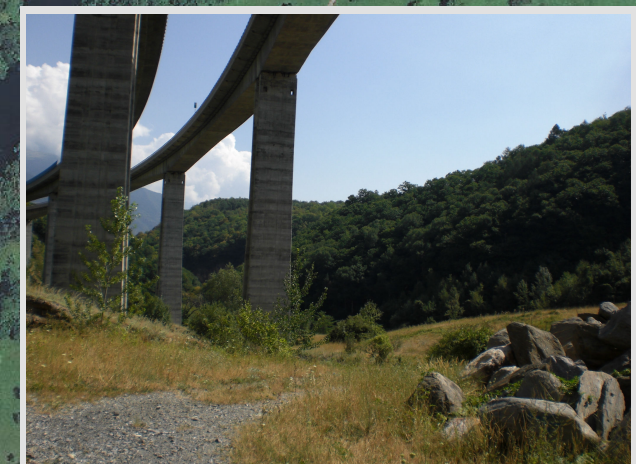
15 - Vista su versante sud
