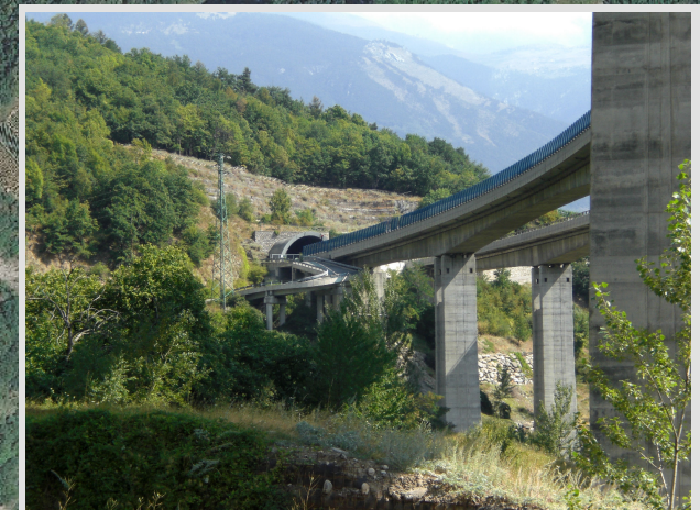
14 - Vista su imbocco ovest galleria Giaglione
