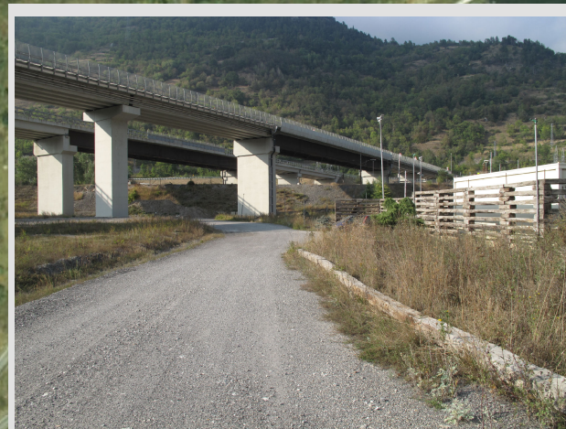
5 - Viadotto - Da est
