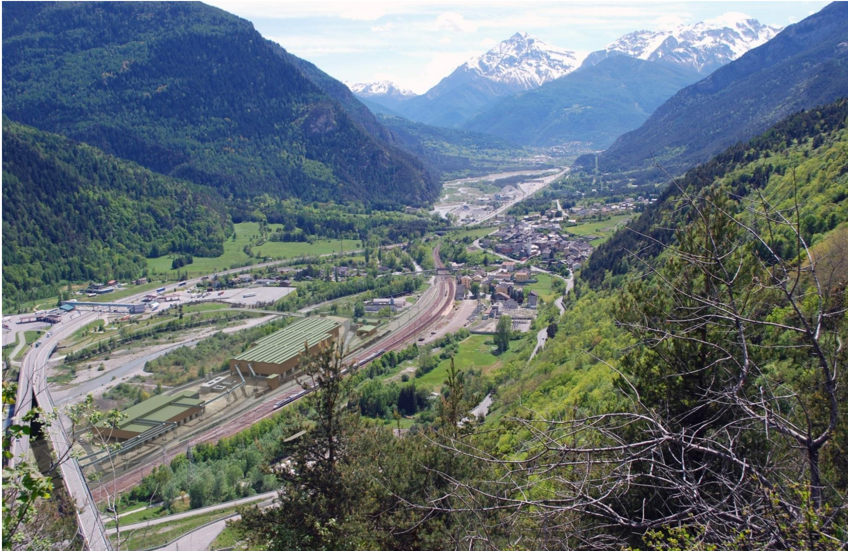
Figura 38 – Cantiere di Salbertrand_vista 1di2
