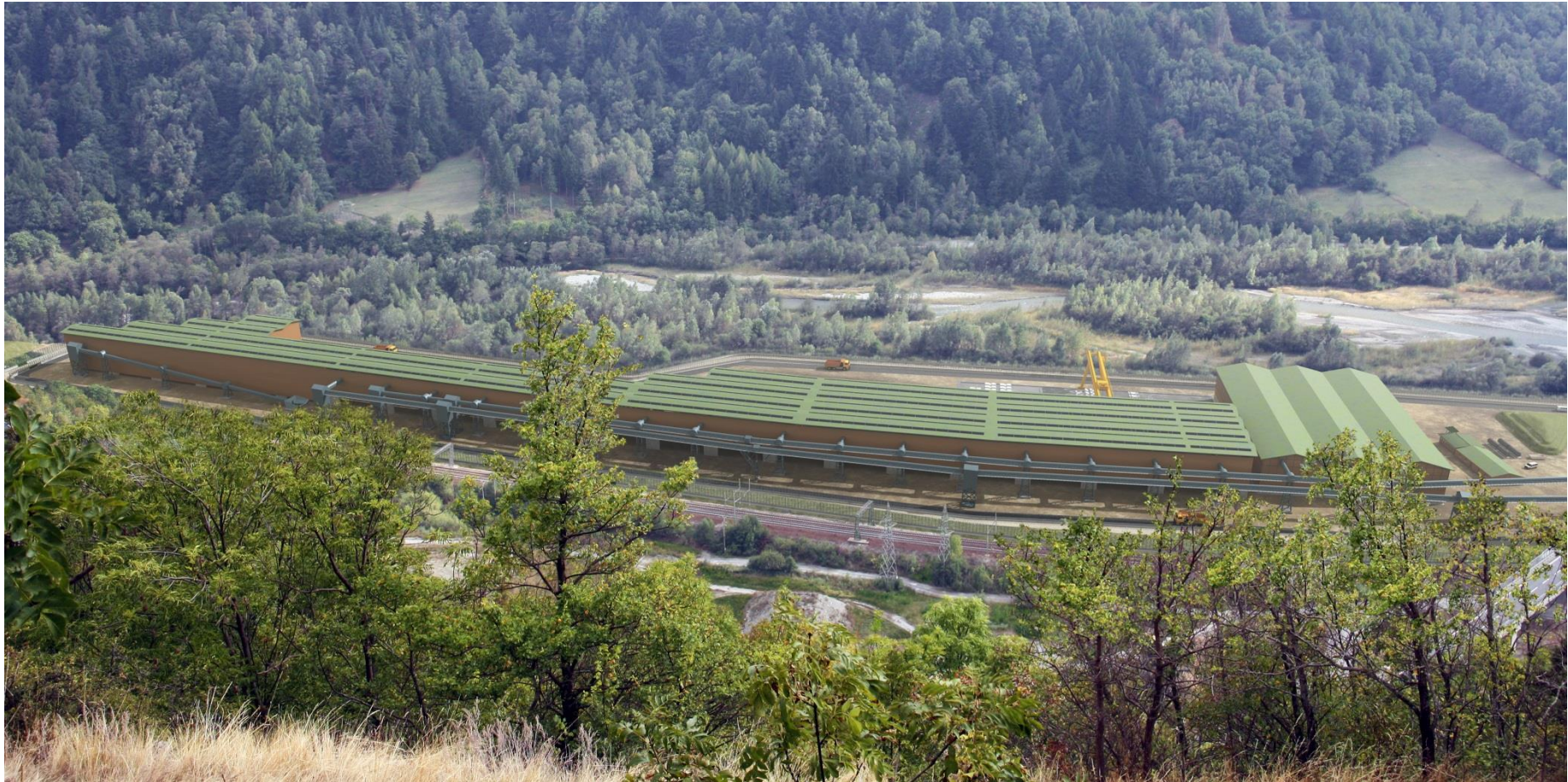
Figura 40 – Cantiere di Salbertrand_vista 2di2
