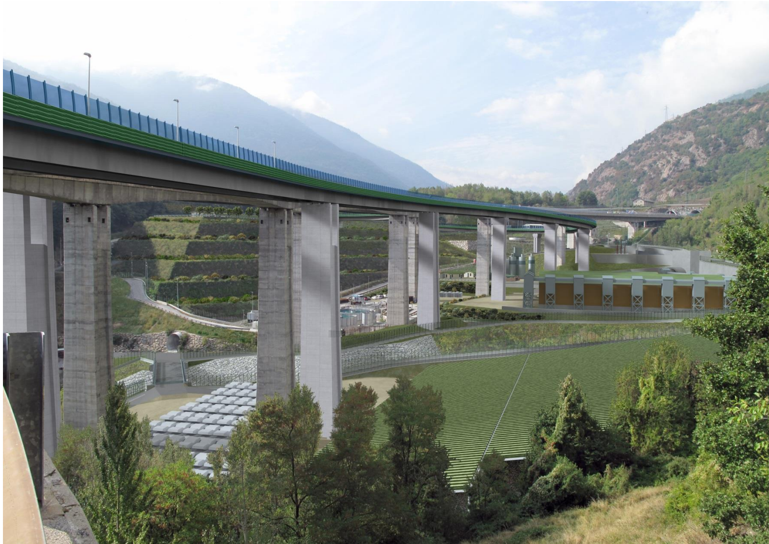
Figura 33 – Area della Maddalena: Fase di cantiere
