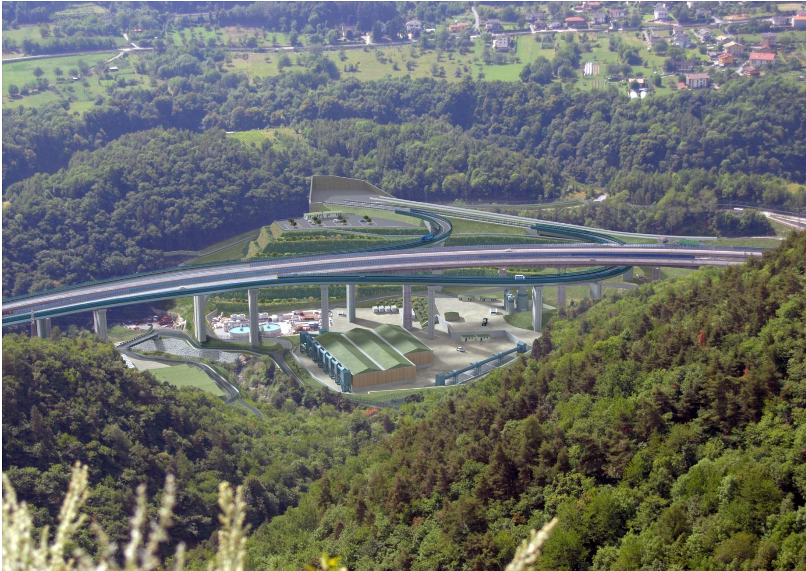
Figura 35 – Area della Maddalena: Fase di cantiere
