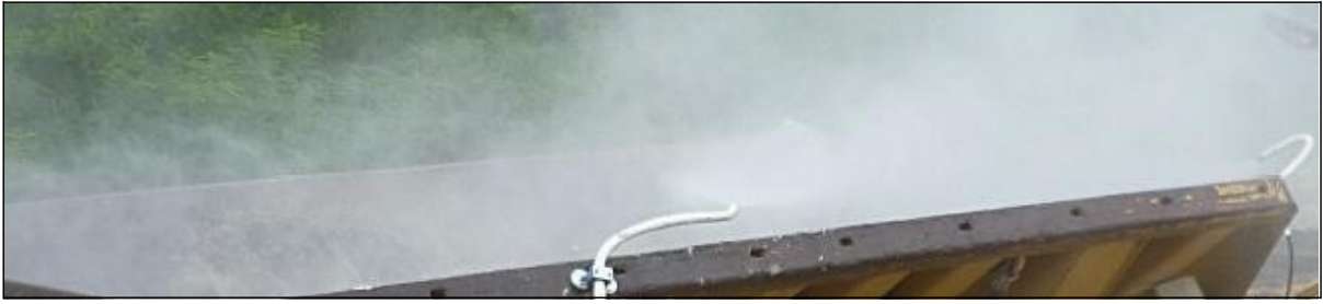
CONFINAMENTO PER APPROVVIGIONAMENTO TBM
