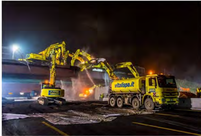
Immagine di esempio di demolizione dell'opera
