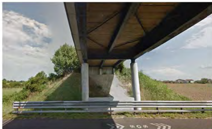
Vista spalle e intradosso impalcato
