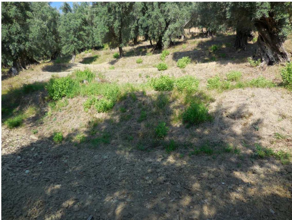
Foto 7 - sostegno 288/2, areale - vista generale
