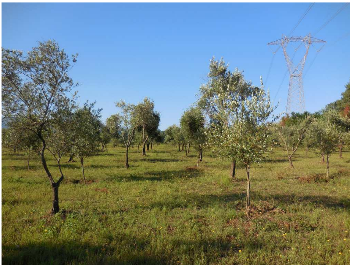
Foto 38 - sostegno 288/8, areale - vista generale
