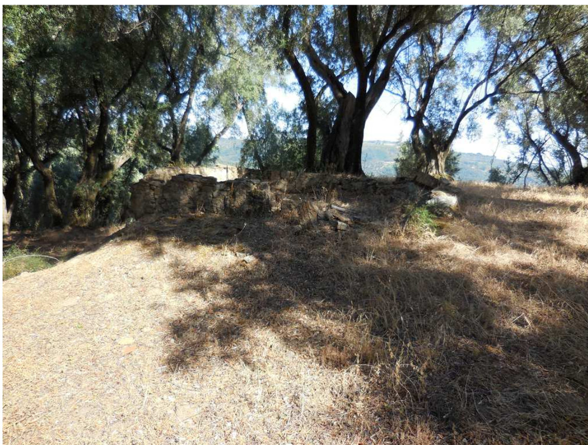
Foto 16 - sostegno 288/3, areale - vista generale della sommità della collina, con rudere moderno
