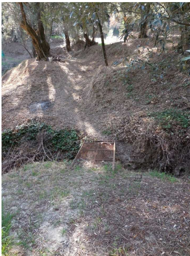
Foto 14 - sostegno 288/3, areale - vista generale
