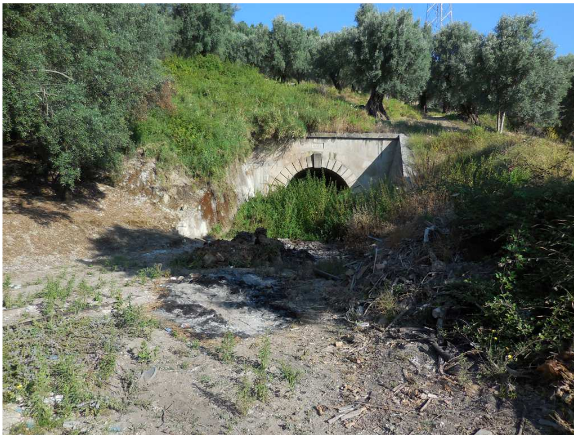
Foto 3 - sostegno 288/1, areale –imbocco della ferrovia calabro-lucana
