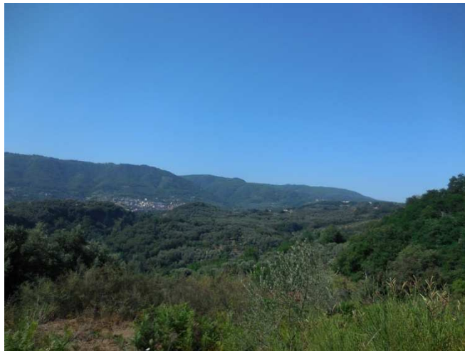
Figura 13 – Il sostegno 288/4 visto dal sostegno 288/5
