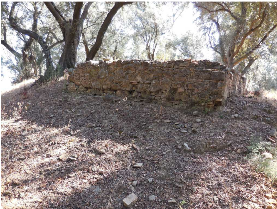
Foto 17 - sostegno 288/3, particolare della struttura moderna
