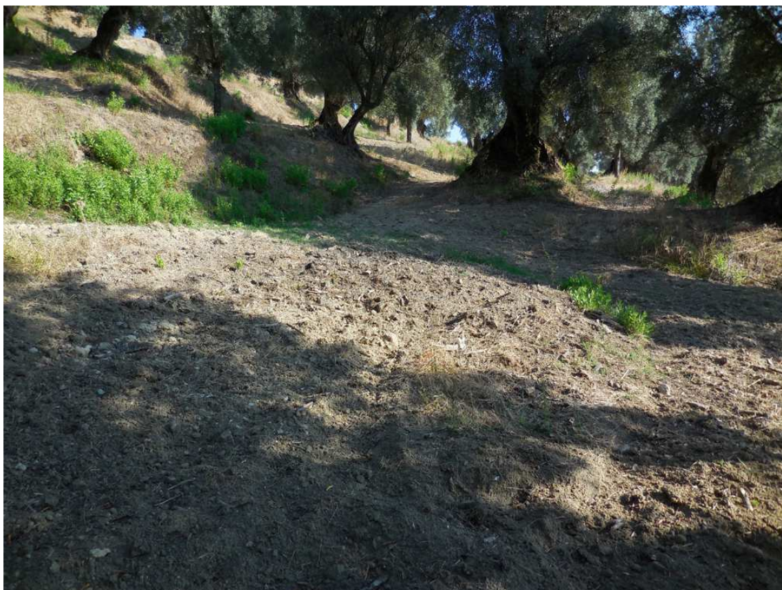
Foto 4 - sostegno 288/1, areale – vista generale
