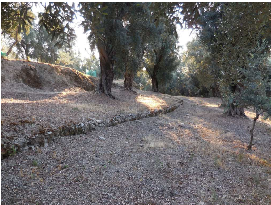
Foto 24 - sostegno 288/4, areale - vista generale
