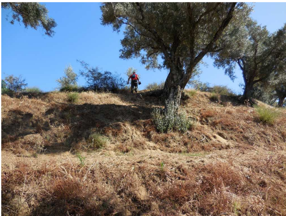
Foto 32 - sostegno 288/5, areale – vista generale
