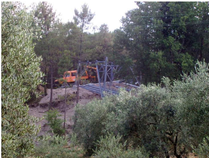
Foto 1 - esempio di area di micro cantiere
