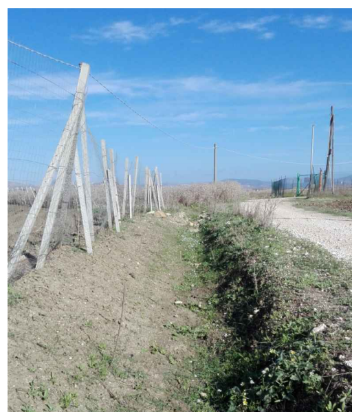
FOTO 09 Fosso adiacente alla strada di accesso area pozzo Gela 57 - vista Sud
