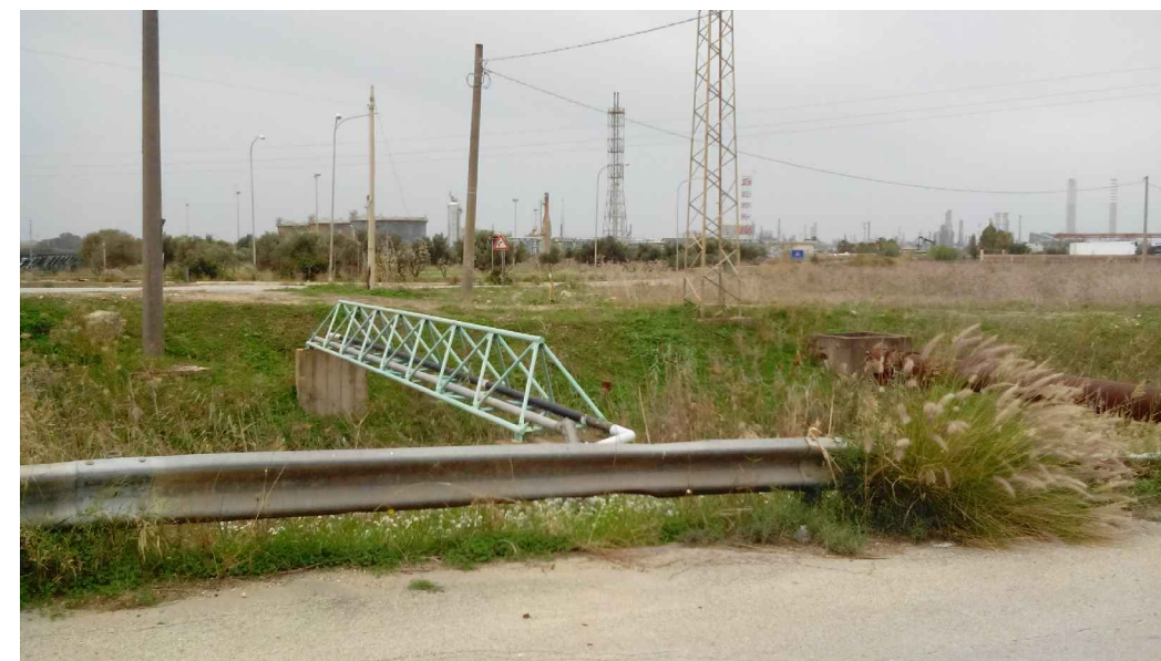
FOTO 14 Canale con condotta - Vista da strada a nord del Canale verso sud
