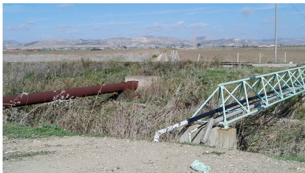
FOTO 13 Canale con condotta - Vista da strada SS 82 verso Nord
