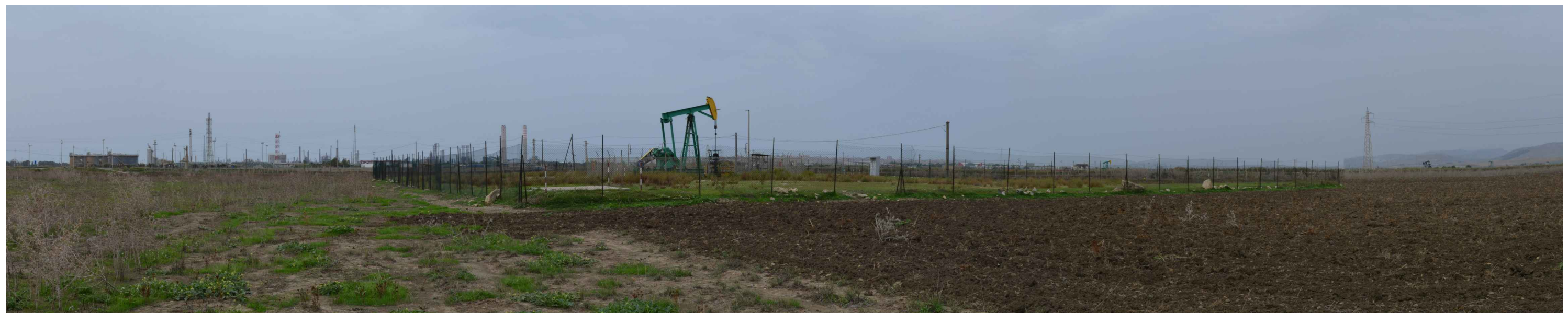
FOTO 02 Area pozzo Gela 57 da Nord Est
