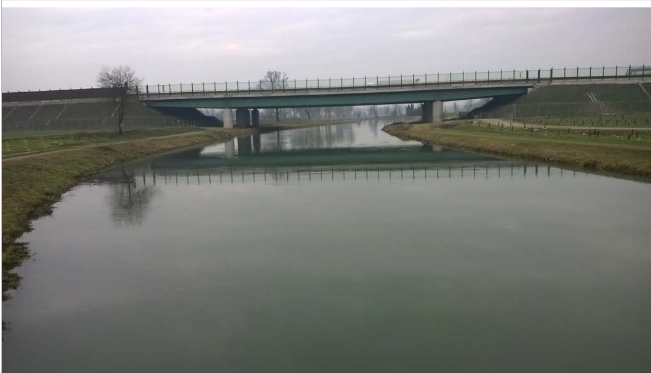
Foto 1 Foto attività di rilievo
