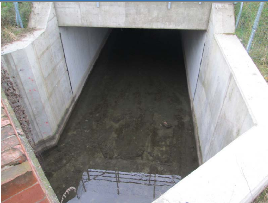
Foto 1 Foto attività di rilievo
