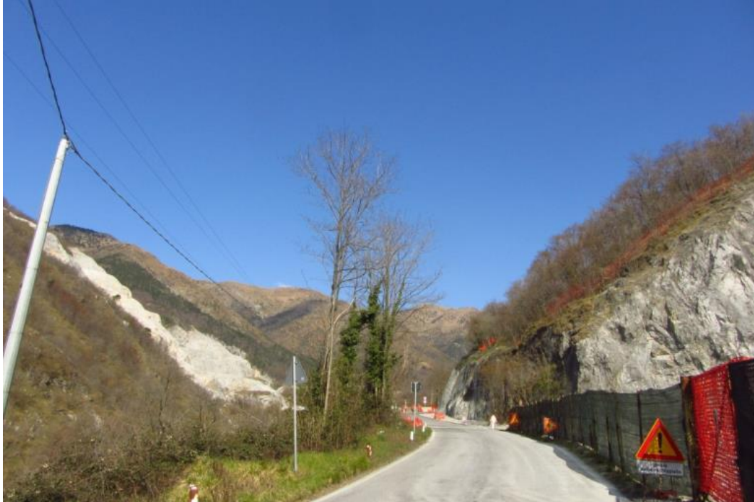
Fig. 1 FAU-CM-040. Panoramica della stazione di monitoraggio.
