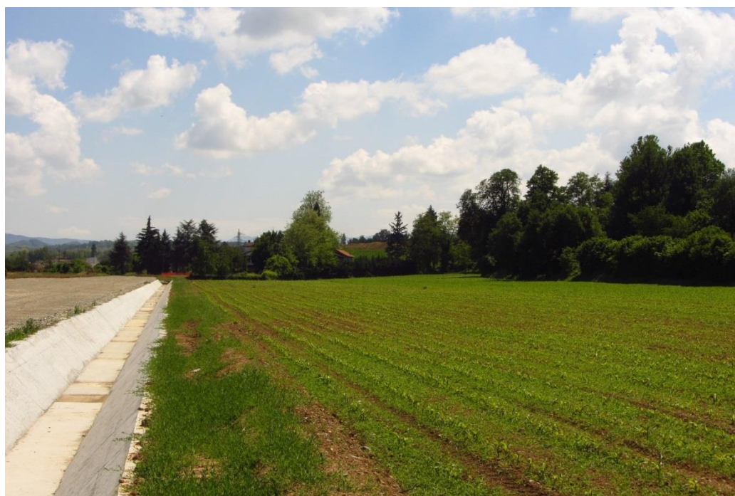
Fig. 2 FAU-NL-020. Panoramica dell'area di indagine
