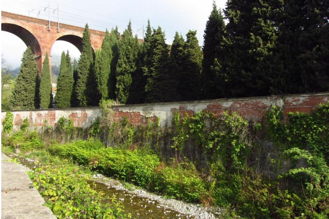
Fig. 1 FAU-GE-060. Veduta dell'area di monitoraggio.
