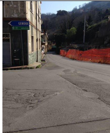
Figura 4-15- Punto di vista 2°A - S.P.6 NV12
