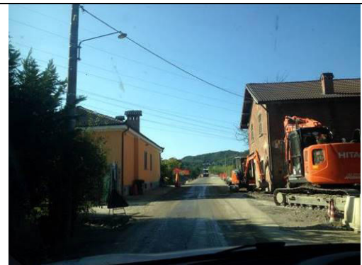
Figura 4-25— Punto di vista 4°A- Via dei Moriassi
