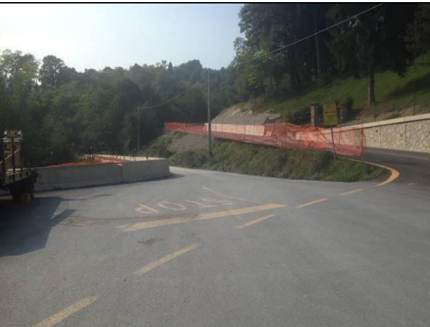
Figura 4-18— Punto di vista 3°A-Vicino Ingresso Cantiere C.O.P.2 in località Casasse
