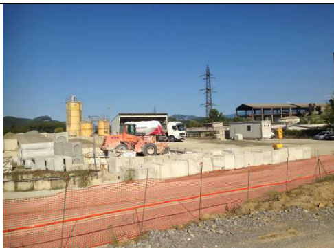
Figura 4-24— Punto di vista 3°A- Via dei Moriassi
