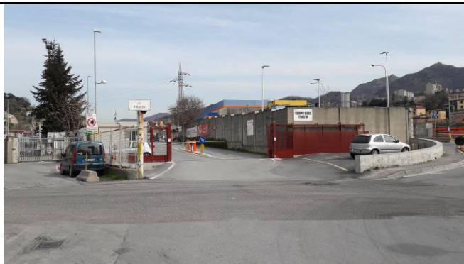
Figura 4-7— Punto di vista 3°C- Ingresso cantiere CBL3
