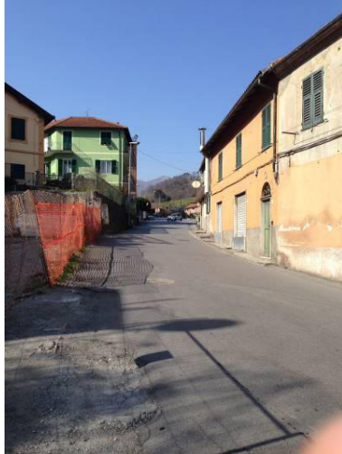
Figura 4-10— Punto di vista 2°A-S.P.6 NV12
