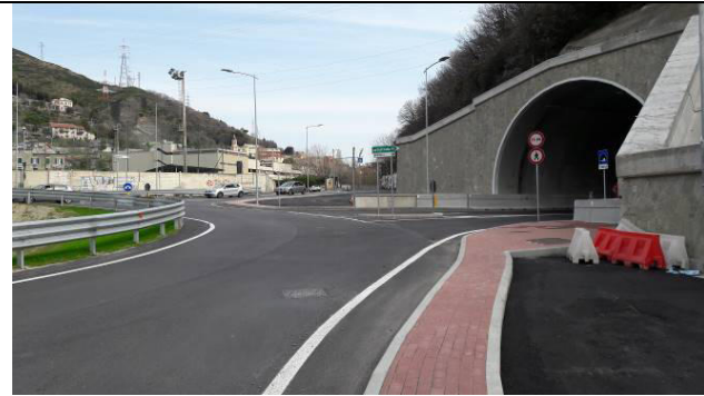
Figura 4-1 – Punto di vista 1°A- cantiere COV1
