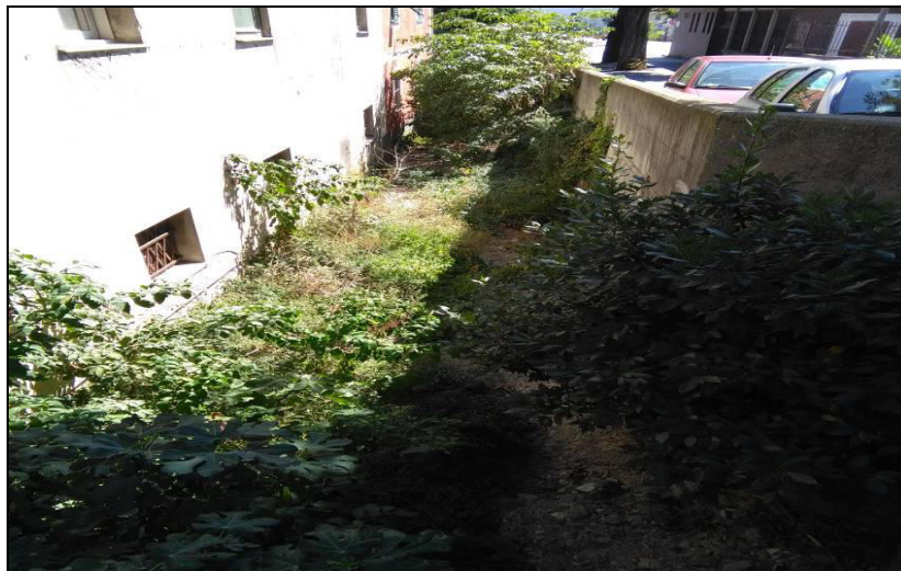
Foto 1 - Stazione T-GE-500 sul Rio Costiera (Agosto 2016)
