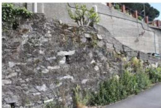
Muro di contenimento Stato di manutenzione: P Localizzazione di massima: Y: 491003.82 m E X: 4922062.28 m N
