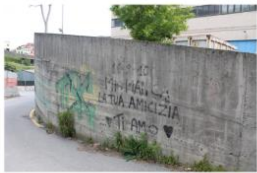
Muro di contenimento Stato di manutenzione: D Localizzazione di massima: Y: 4921961.51 m N
