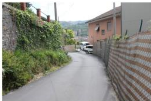
Vista generale 'Salita Ca dei Trenta' Stato di manutenzione: P Localizzazione di massima: Y: 4922052.62 m N X: 491031.21 m E
