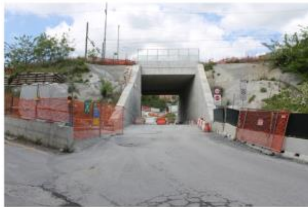
Nuovo ingresso area di cantiere
