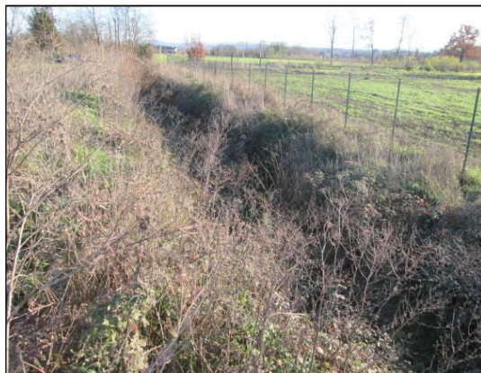
Foto 6 - Stazione T-NL-520 sul Canale Lodolino (Novembre 2016)
