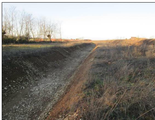
Foto 7 - Stazione T-NL-540 sul Canale Lodolino (Novembre 2016)
