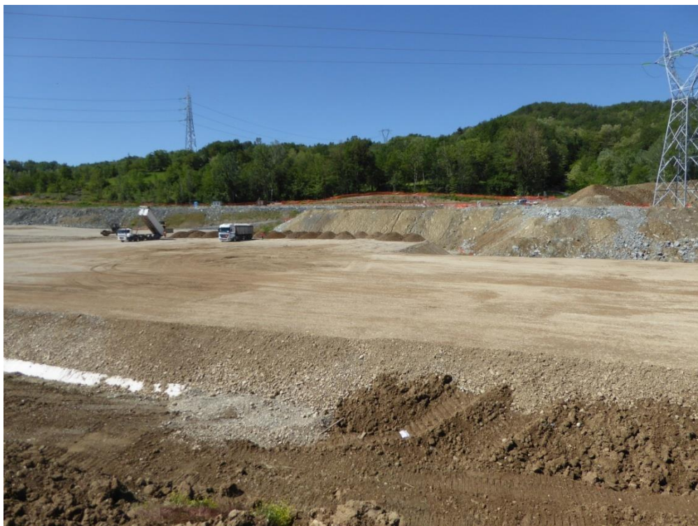
Figura 13.17.3: panoramica stazione di rilievo VEG-SS-500D
