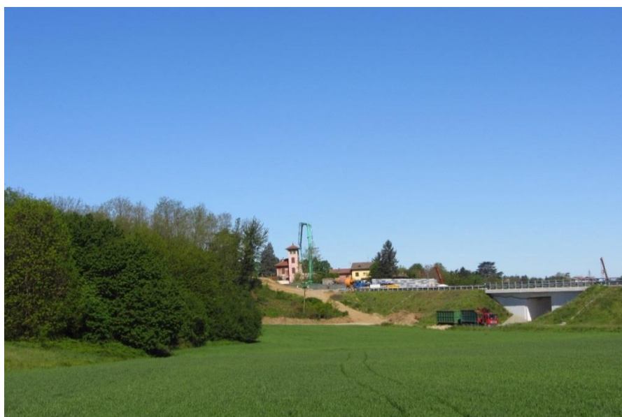
Fig. 1 FAU-NL-010. Panoramica dell'area di indagine
