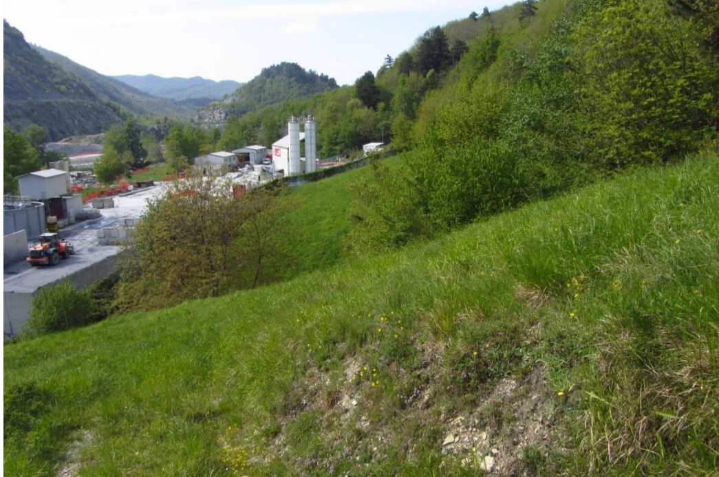
Fig. 2 FAU-VO-020_B. Panoramica dell'area di studio.
