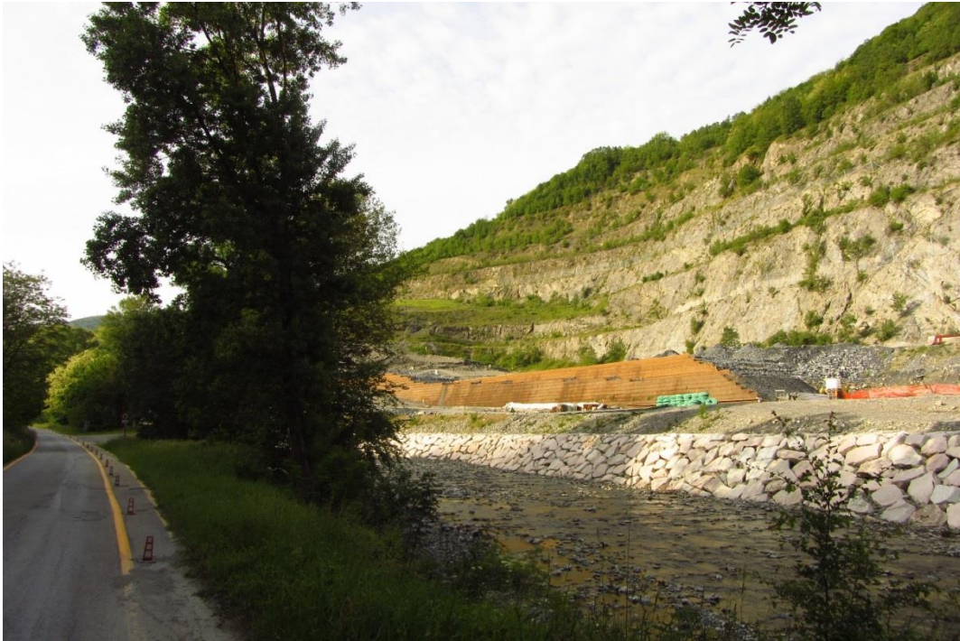
Fig. 2 FAU-VO-020. Panoramica dell'area di studio.
