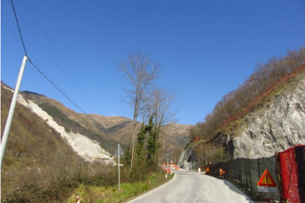
Fig. 1 FAU-CM-040. Panoramica della stazione di monitoraggio.
