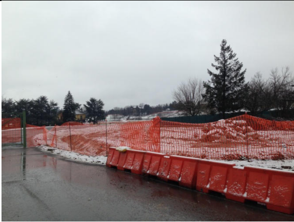
Figura 4-9— Punto di vista 1°A-Ingresso al cantiere D.P.06
