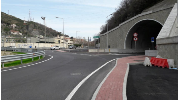
Figura 4-1 – Punto di vista 1°A- cantiere COV1
