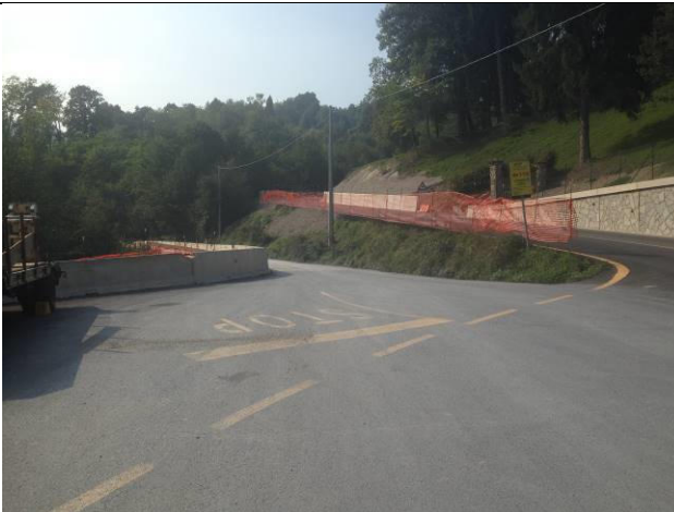
Figura 4-15— Punto di vista 3°A-Vicino Ingresso Cantiere C.O.P.2 in località Casasse
