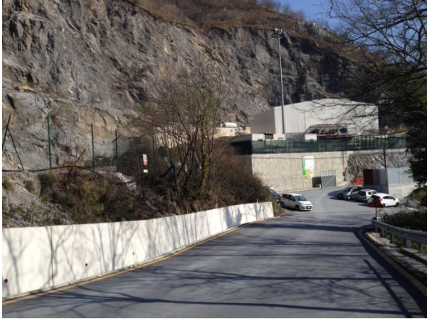
Figura 4-9— Punto di vista 1°A- Ingresso del cantiere C.S.L.2 lungo la S.P.6
