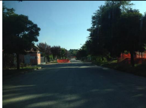
Figura 4-20— Punto di vista 2°B-Esterno ingresso C.O.P.5
