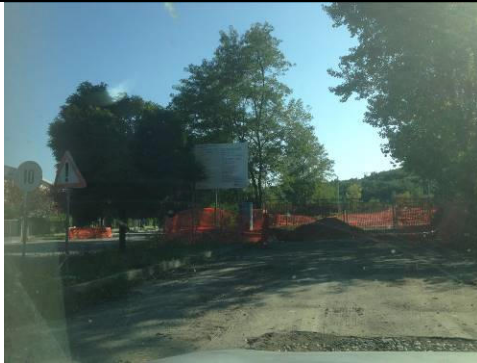
Figura 4-19— Punto di vista 2°A- Ingresso C.O.P.5 sottostante la S.P.161
