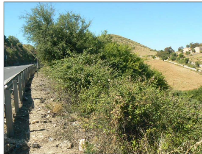
Figura C.6: esemplari arboreo-arbustivi cresciuti sul rilevato stradale
