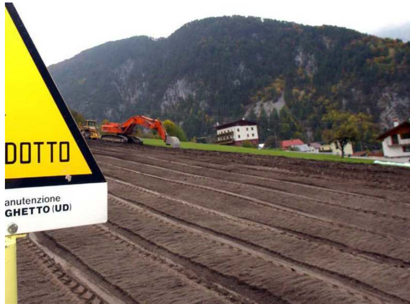
Fig. 2.1/H: Esempio di redistribuzione dello strato superficiale
