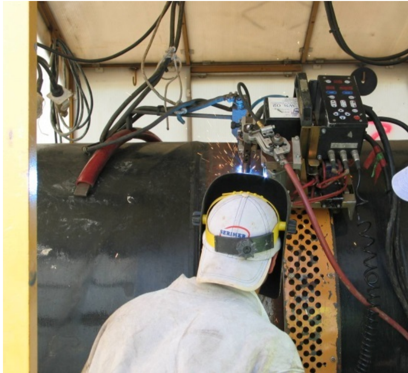
Fig. 2.1/D: Esempio di saldatura di linea
