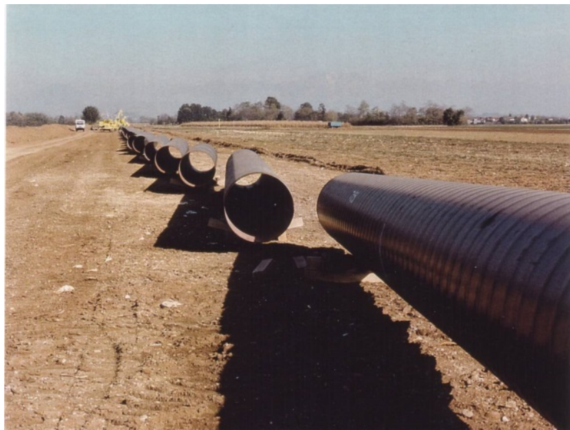
Fig. 2.1/C: Esempio di sfilamento tubazioni
