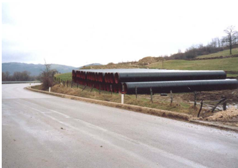
Fig. 2.1/A: Esempio di piazzola di accatastamento tubazioni
