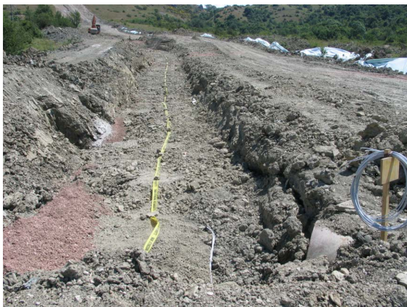
Fig. 2.1/G: Esempio di rinterro della condotta
