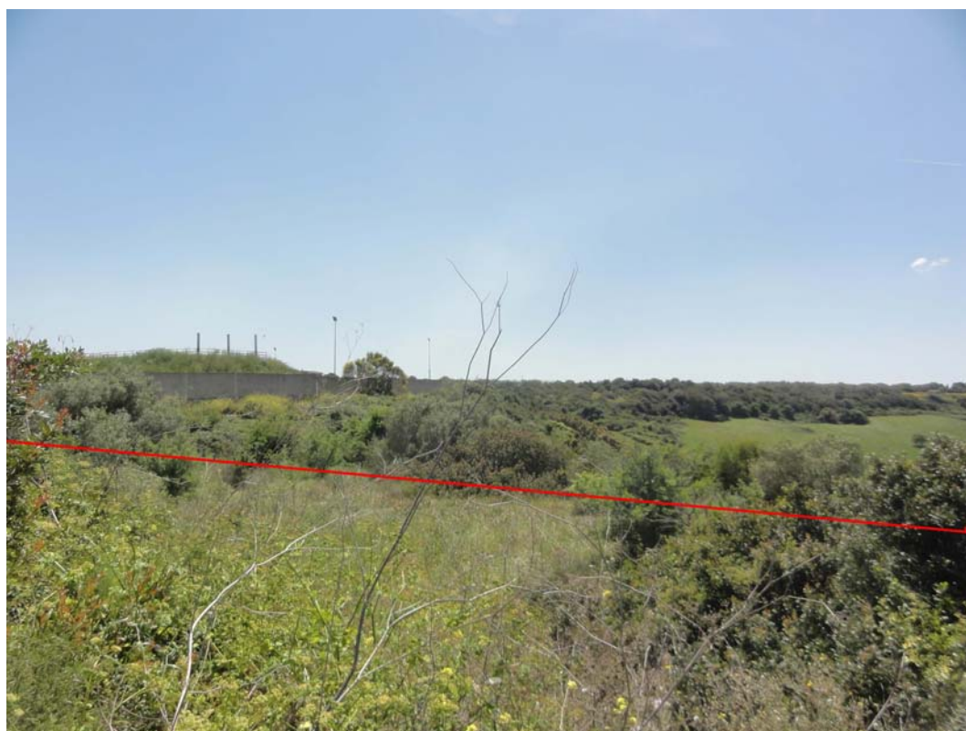
Foto 6: Tratto terminale presso impianto Hera
