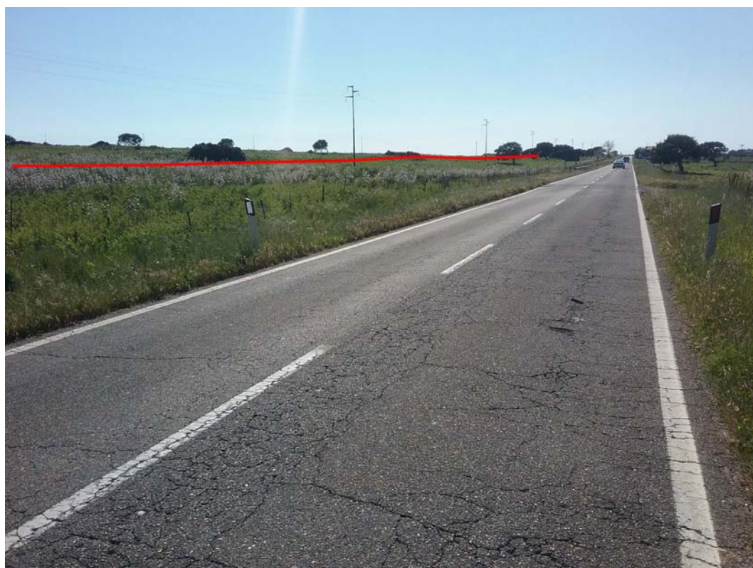
Foto 6: Panoramica dalla Strada Statale n°129 bis
