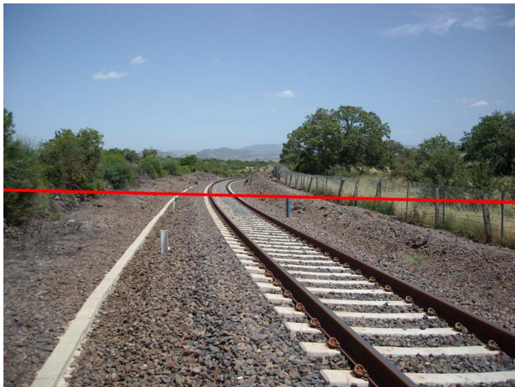
Foto 17: Attraversamento F.S. Cagliari – Sassari
