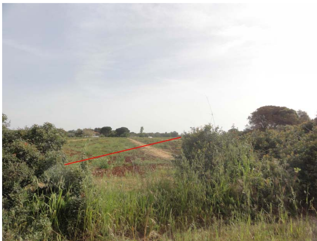
Foto 2: Vista Nord da Loc. Casello n. 13
