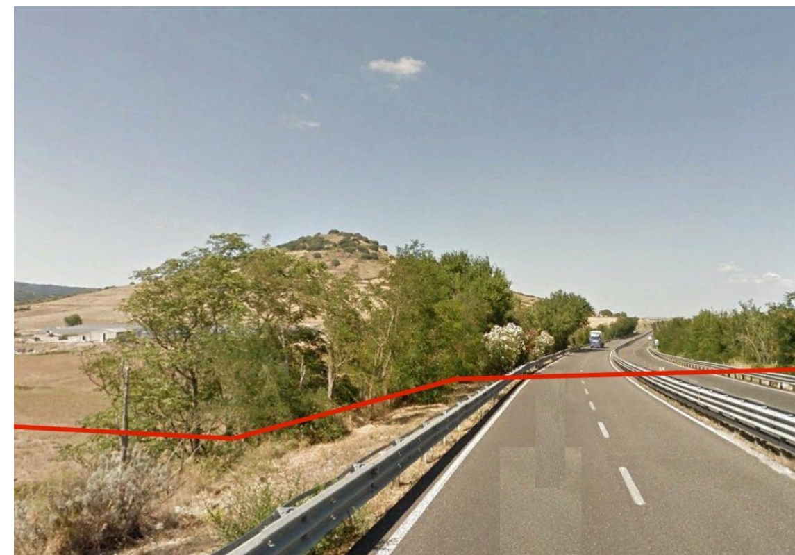
Foto 4: Attraversamento Strada Statale n°131
