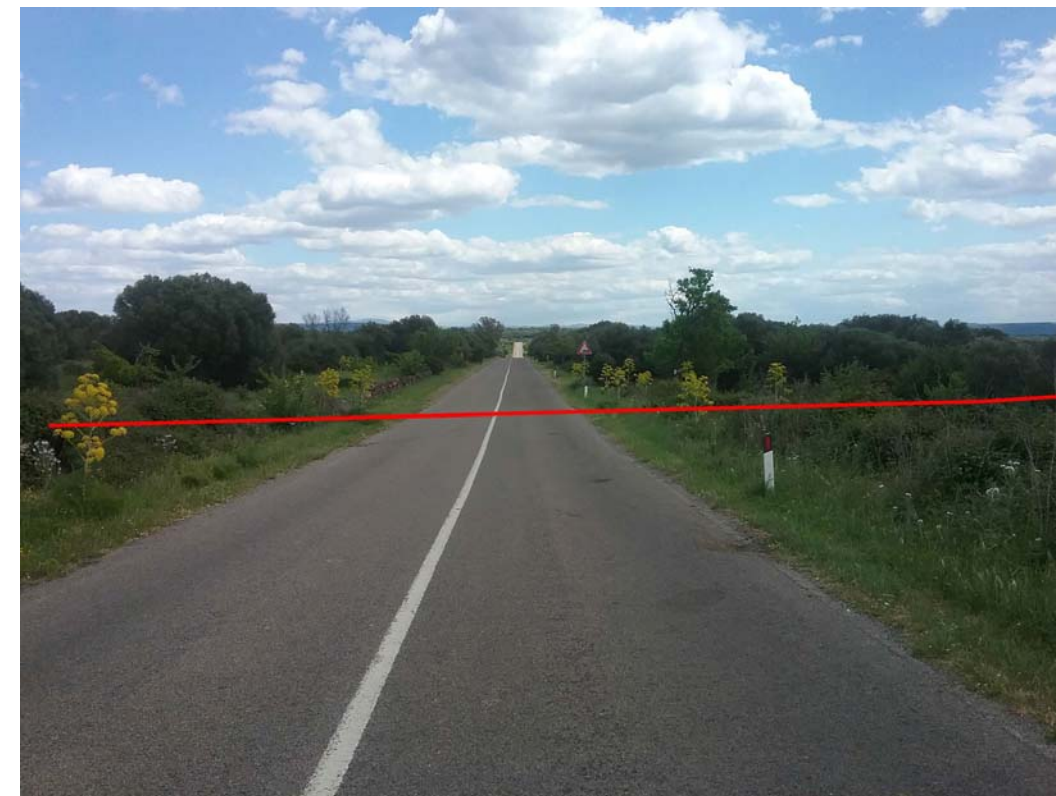
Foto 15: Attraversamento Strada Provinciale n° 11
