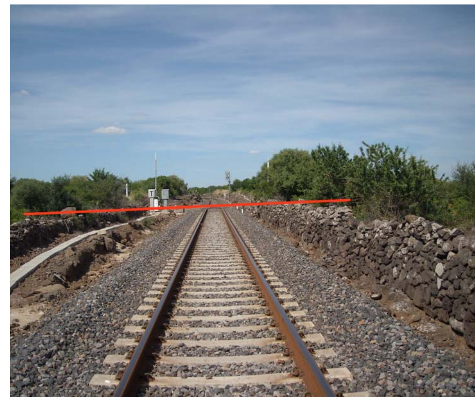
Foto 16: Attraversamento Ferrovia Cagliari - Sassari
