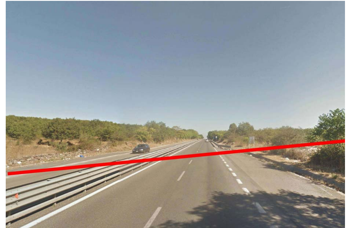
Foto 7: Attraversamento Strada Statale 131
