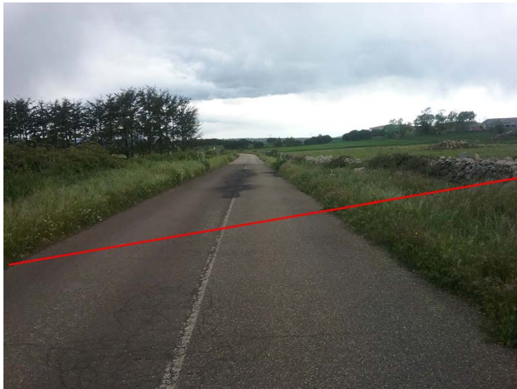
Foto 1: Attraversamento Strada Provinciale 44
