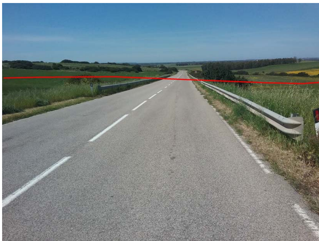
Foto 2: Panoramica Attraversamento Strada Prov.le n°68
