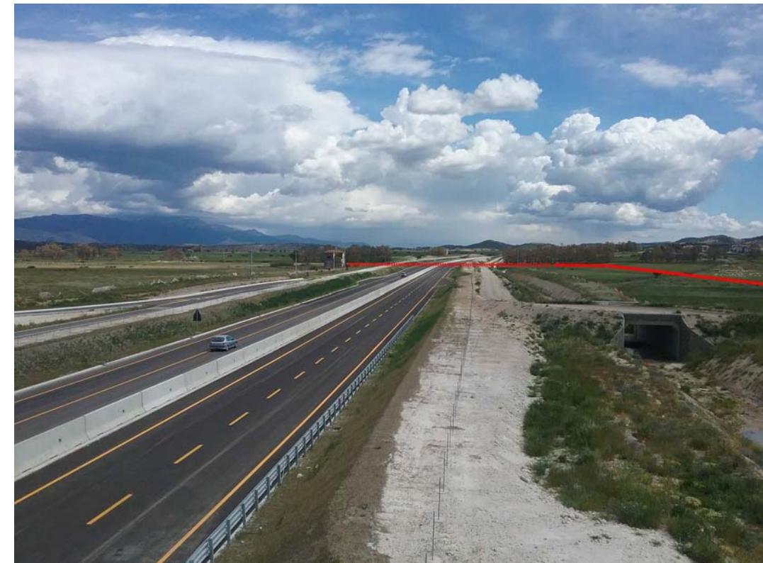
Foto 27: Attraversamento SS 597 e SS 729 (in fase di costruzione)
