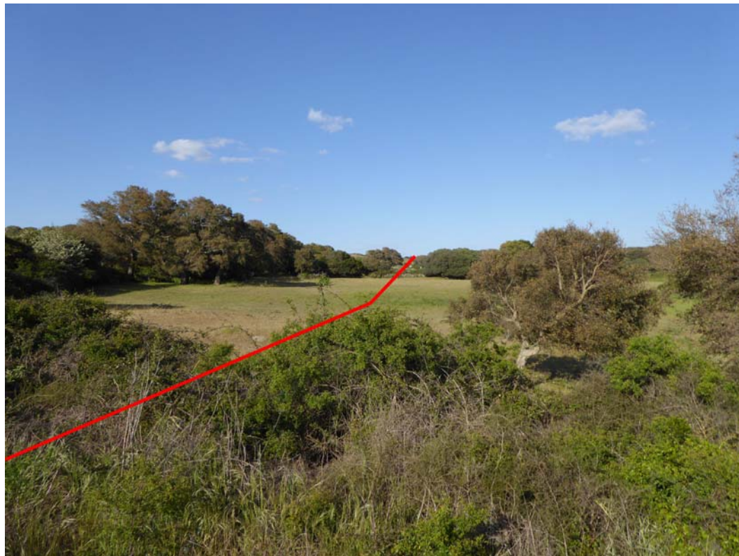
Foto 37: Passaggio in loc. Contra Longa (Comune di Monti) a valle (senso gas) della SP 147
