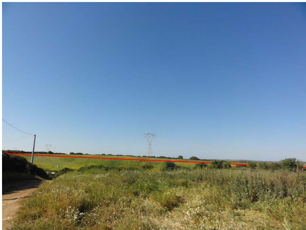
Foto 29: Vista Nord parallelismo con linea AT da Loc. Domo Musina
