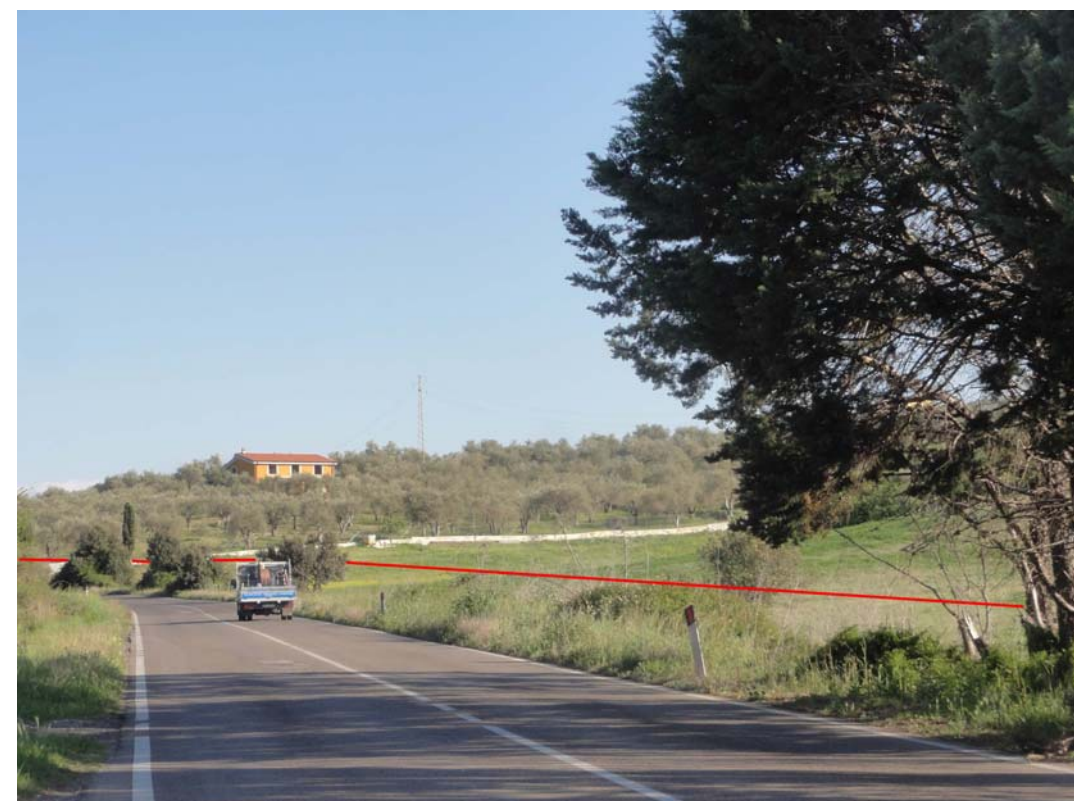
Foto 24: Vista Sud parallelismo con SP n 15-M Loc. Domo Mulas
