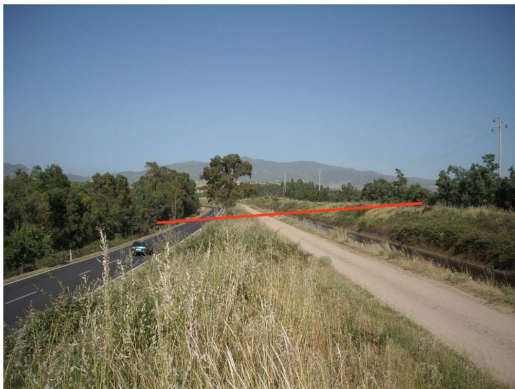
Foto 6: Attraversamento del Canale Adduttore Tirso Arbore e Strada Statale n° 338
