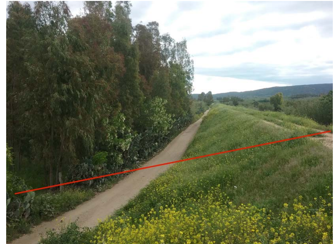
Foto 7 Attraversamento Argine Fiume Tirso
