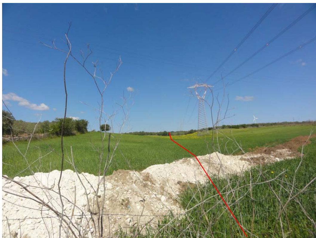
Foto 26: Vista Nord parallelismo con linea AT Loc. Sant'Alene
