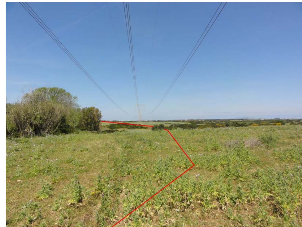
Foto 31: Parallelismo con Linea AT vista Nord da loc. Podere n. 90
