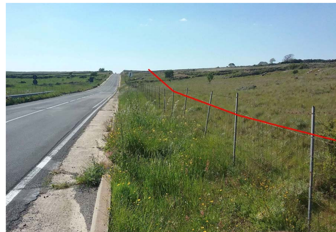
Foto 4: Panoramica dalla Strada Statale n°129 bis
