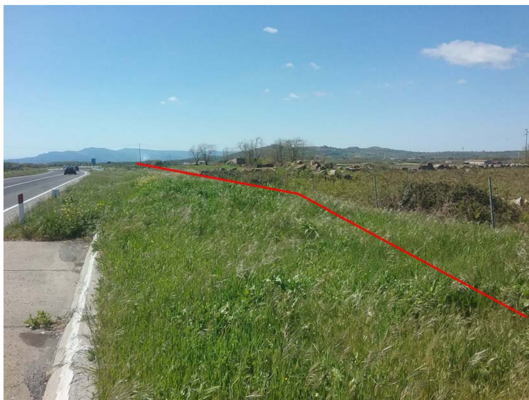
Foto 2: Panoramica dalla Strada Statale n°129 bis
