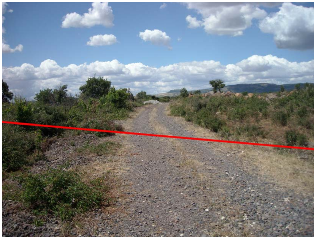
Foto 6: Attraversamento del tratto di F.S. dismessa
