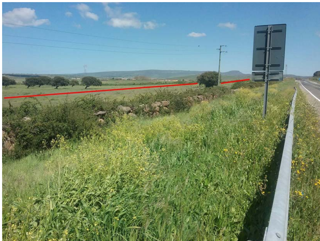
Foto 1: Panoramica dalla Strada Statale n°129 bis
