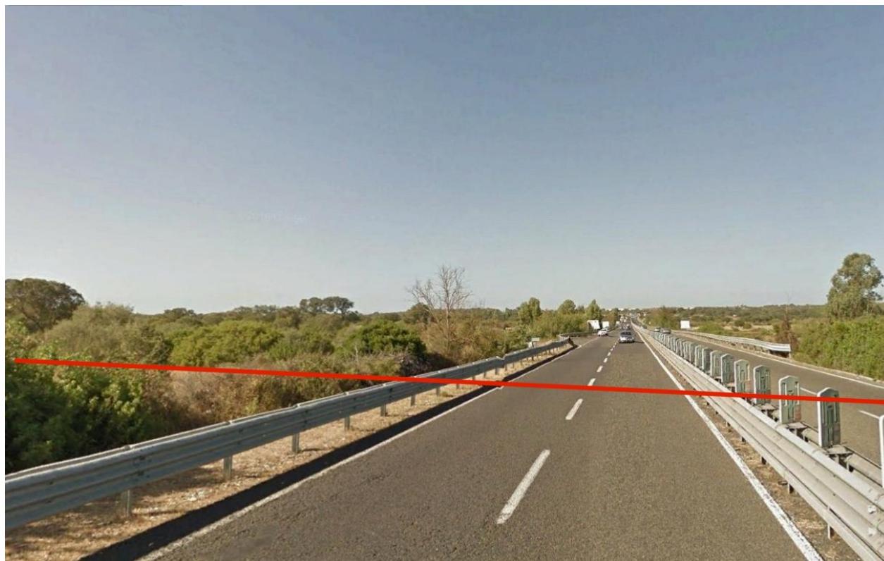
Foto 17: Attraversamento Strada Statale n°131
