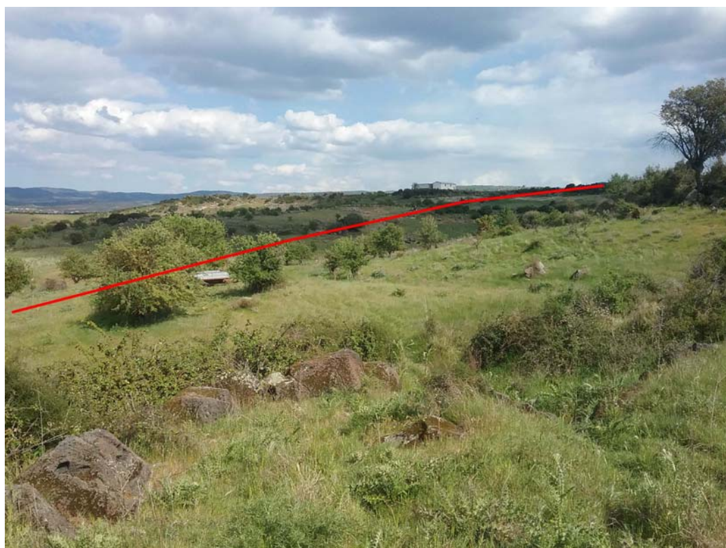
Foto 18: Panoramica del tracciato in loc. Todoracche
