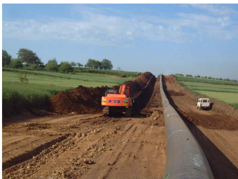
Figura 3/D: Esempio di scavo in trincea
