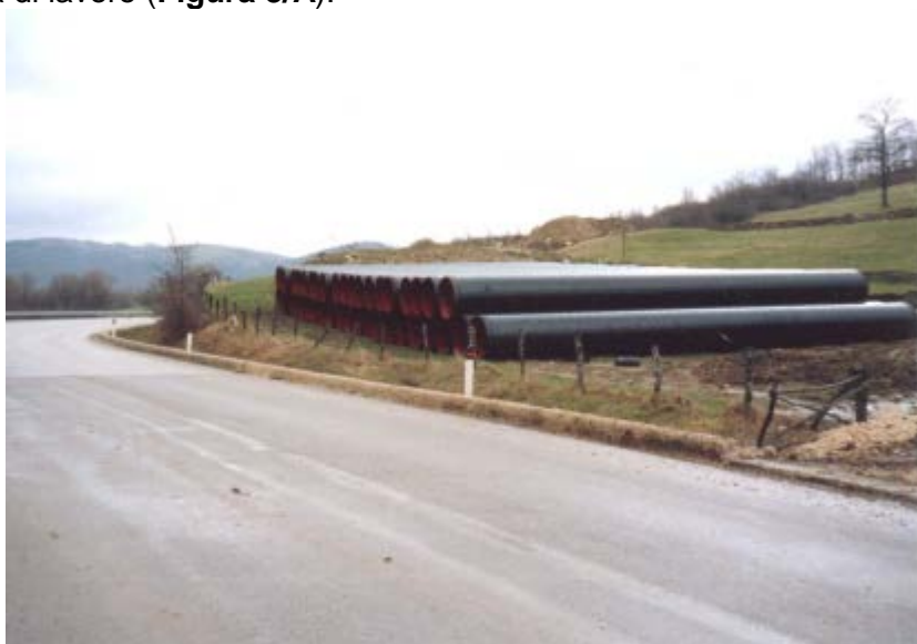
Figura 3/A: Esempio di piazzola di accatastamento tubazioni
