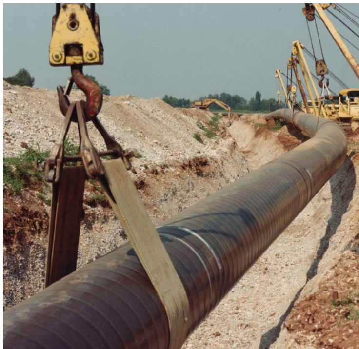
Figura 3/E: Esempio di posa della condotta
