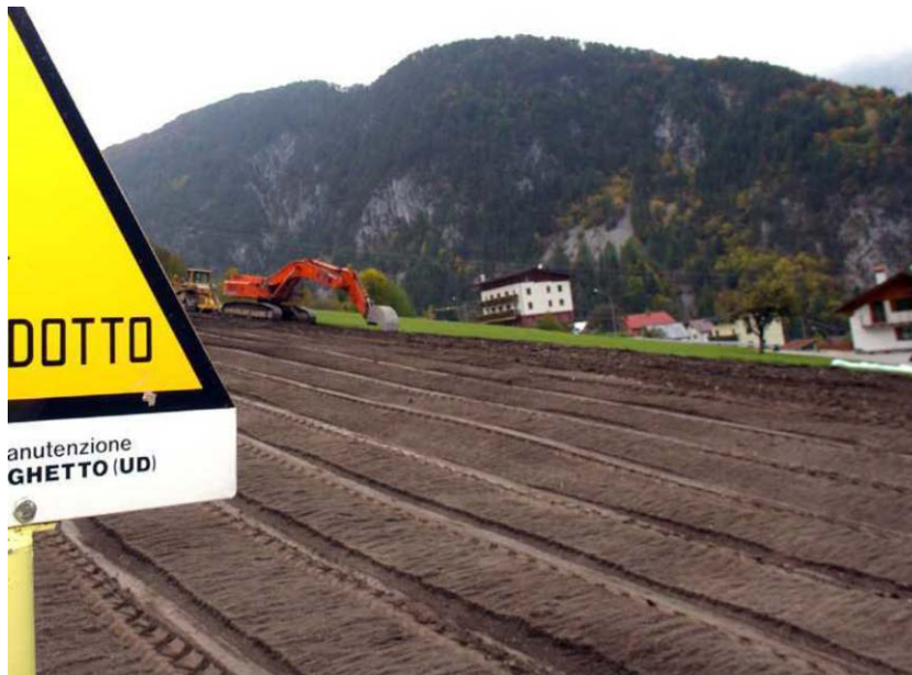
Figura 3/G: Esempio di redistribuzione dello strato superficiale
