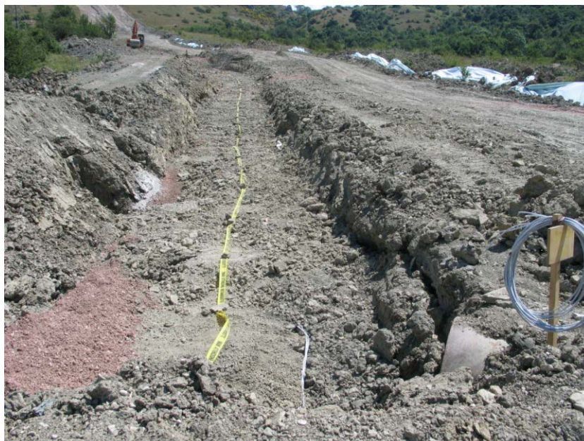
Figura 3/F: Esempio di rinterro della condotta
