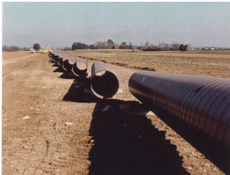
Figura 3/C: Esempio di sfilamento tubazioni
