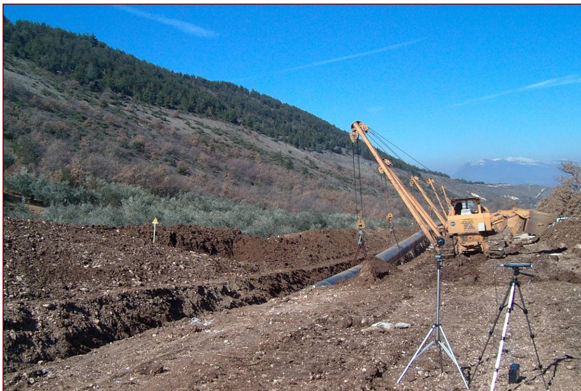
Figura 5/A: Rilievi acustici durante l'operazione di posa della condotta
