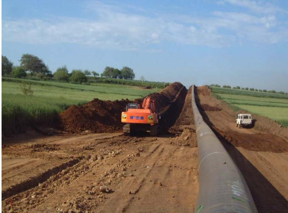
**Fig. 3.1.E:** Esempio di scavo in trincea
