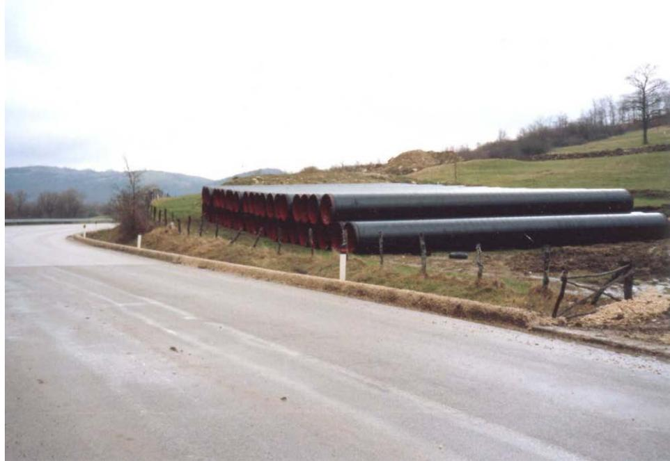
**Fig. 3.1.A:** Esempio di piazzola di accatastamento tubazioni
