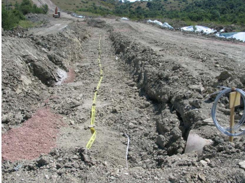
**Fig. 3.1.G:** Esempio di rinterro della condotta
