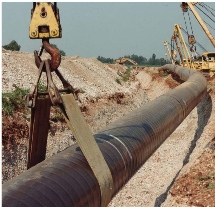
**Fig. 3.1.F:** Esempio di posa della condotta
