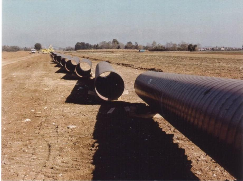
**Fig. 3.1.C:** Esempio di sfilamento tubazioni
