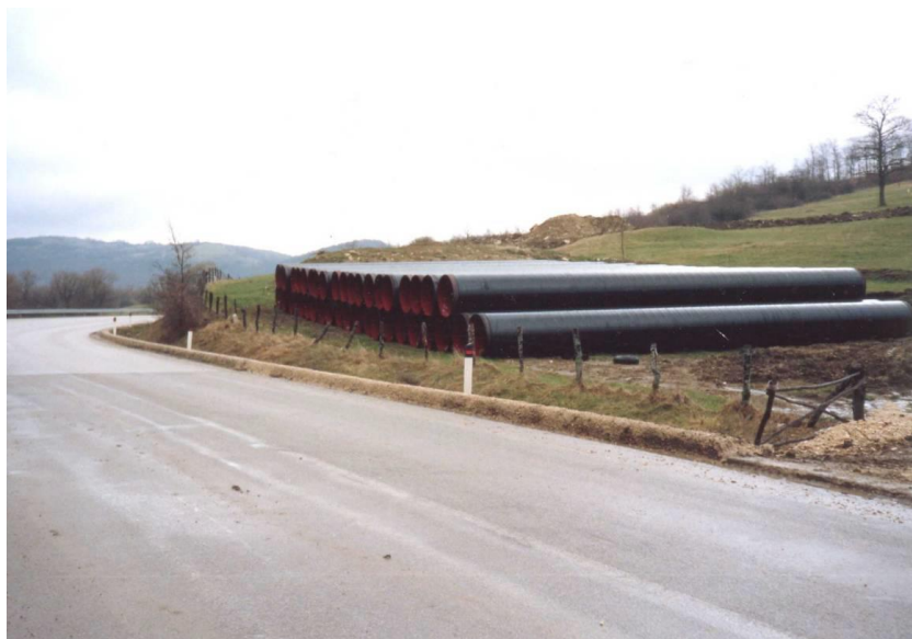
Fig. 5/A: Esempio di piazzola di accatastamento tubazioni
