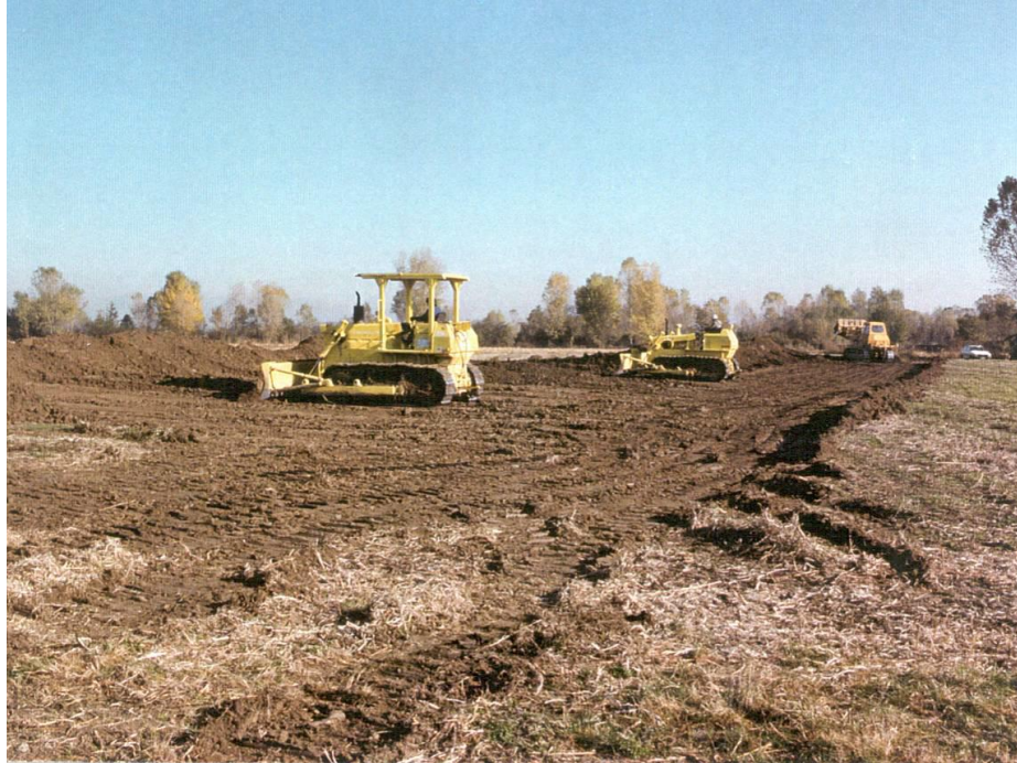
Fig. 5/B: Esempio della fase di apertura dell'area di passaggio
