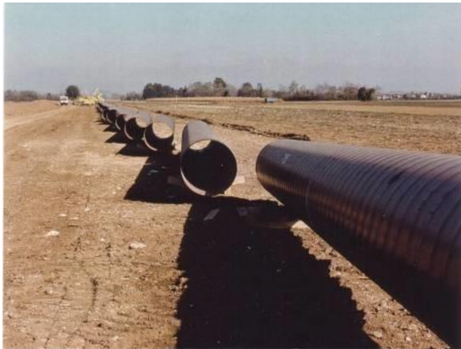
Fig. 5/C: Esempio della fase di sfilamento tubazioni
