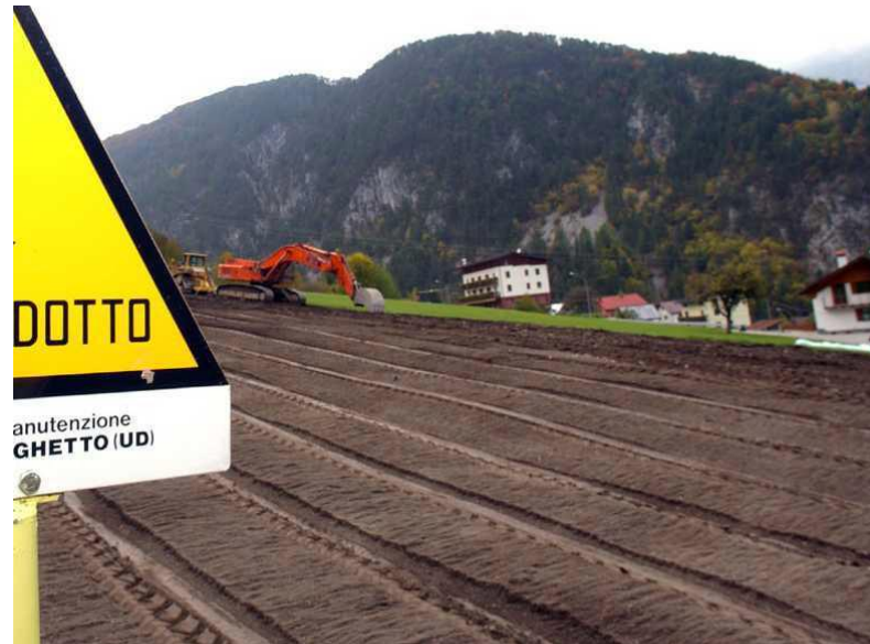
Fig. 5/H: Esempio di redistribuzione dello strato superficiale di suolo (topsoil)
