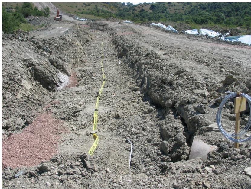
Fig. 5/G: Esempio di rinterro della condotta
