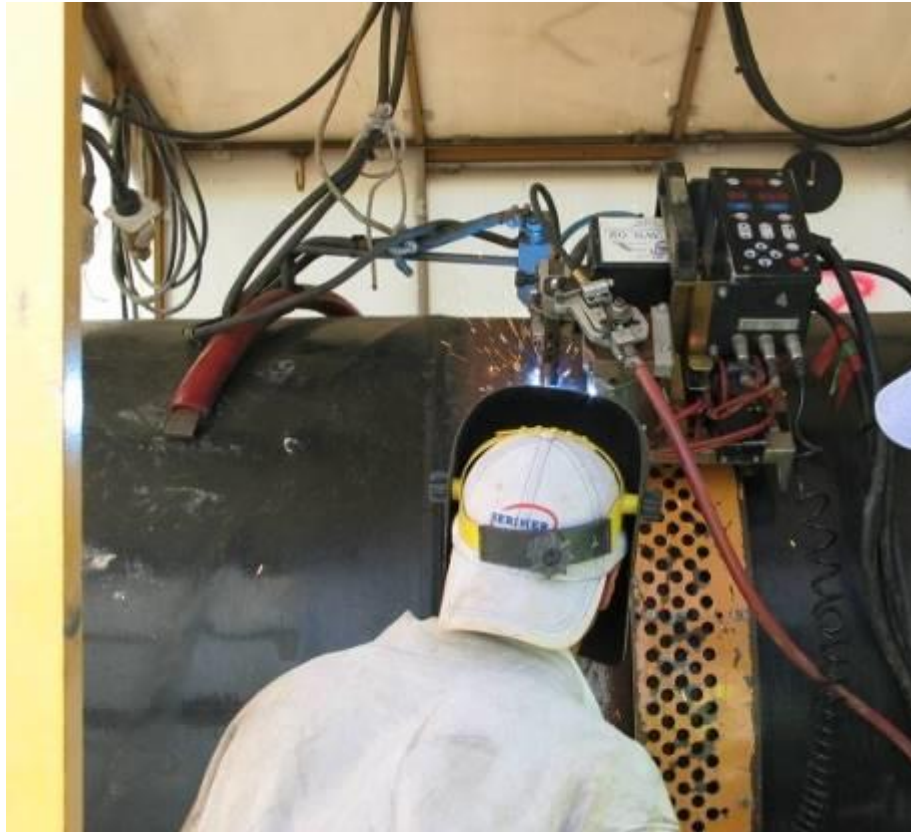
Fig. 5/D: Esempio di saldatura di linea
