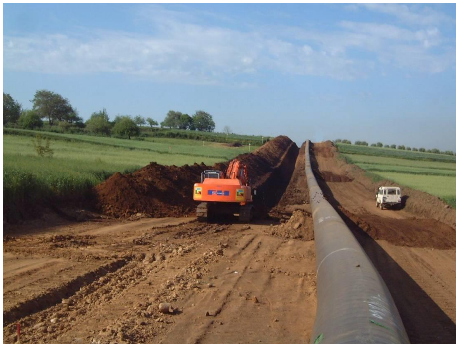
Fig. 5/E: Esempio di scavo della trincea
