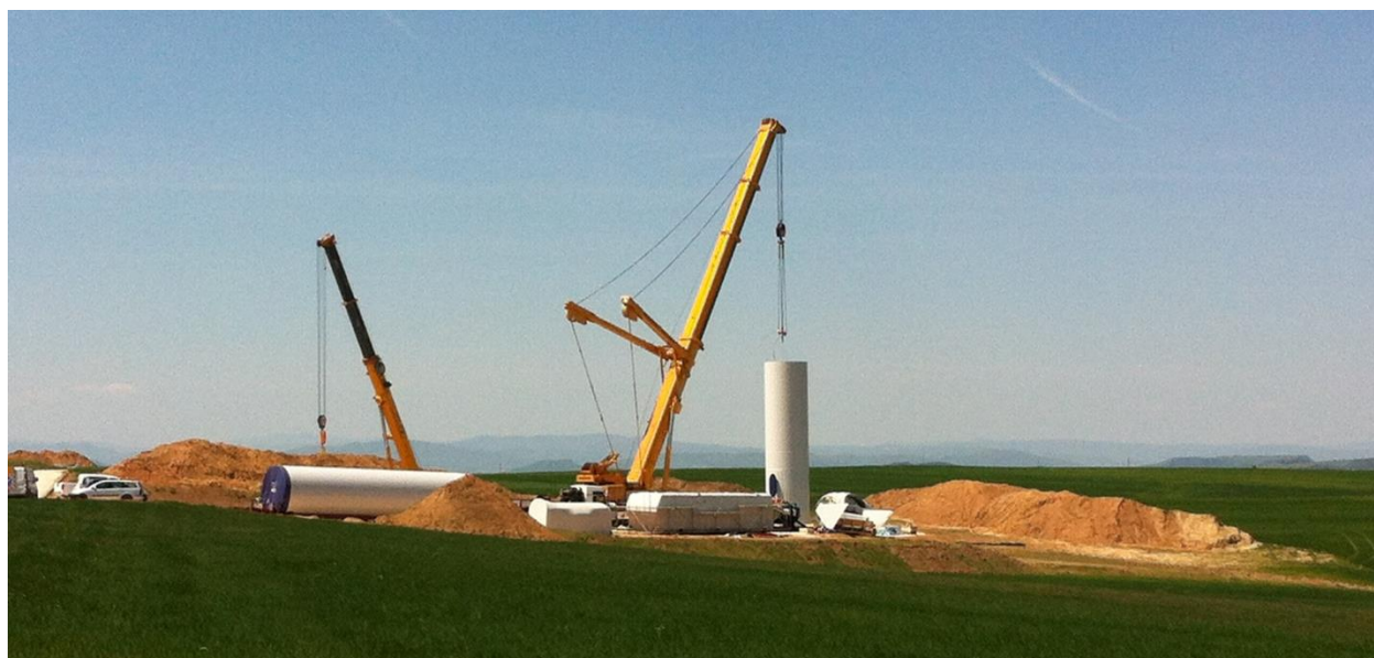
Fig. 2.9 - Montaggio 1° segmento aerogeneratore
