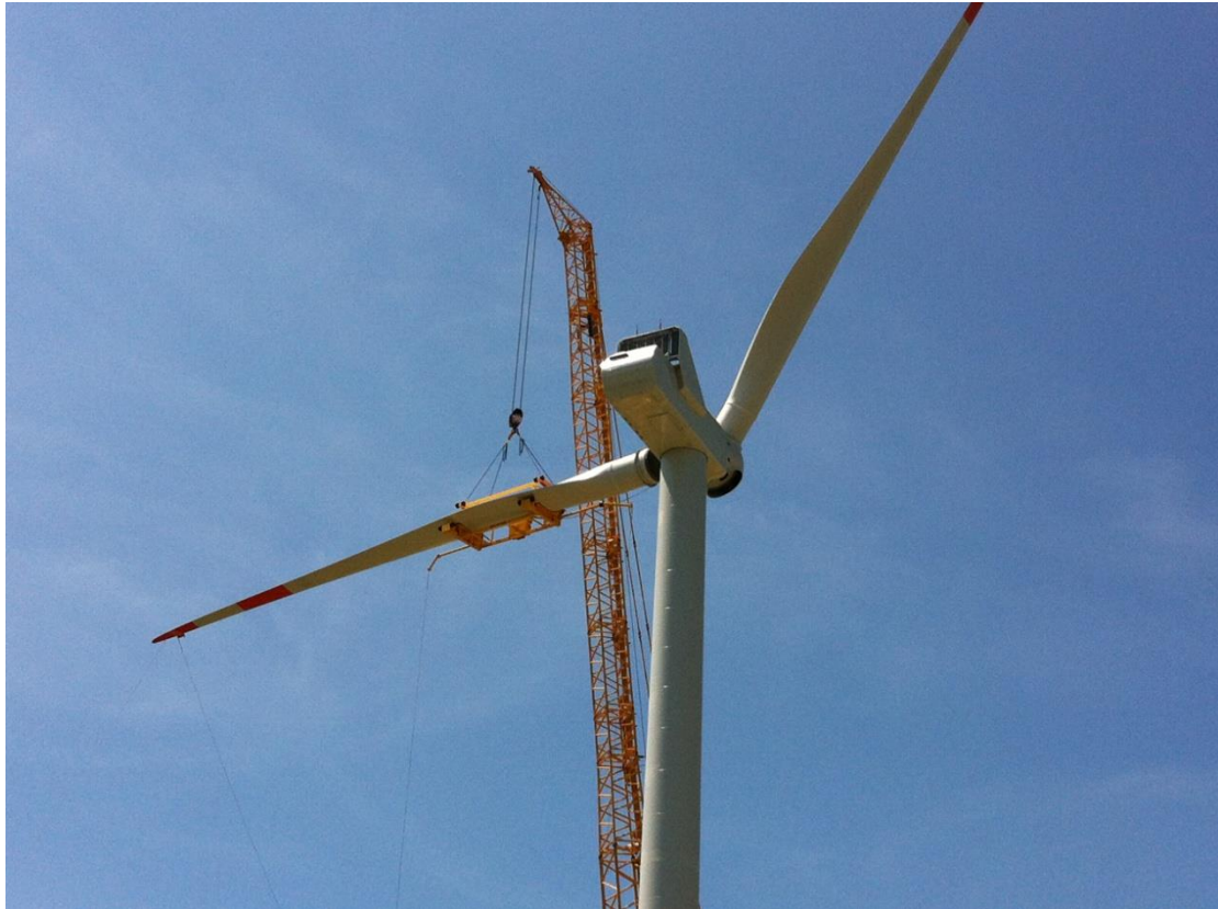
Fig. 2.12 - Montaggio aerogeneratore
