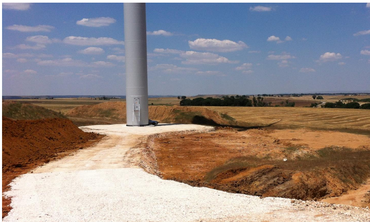
Fig. 2.4 - Piazzola Definitiva con Accesso Stradale
