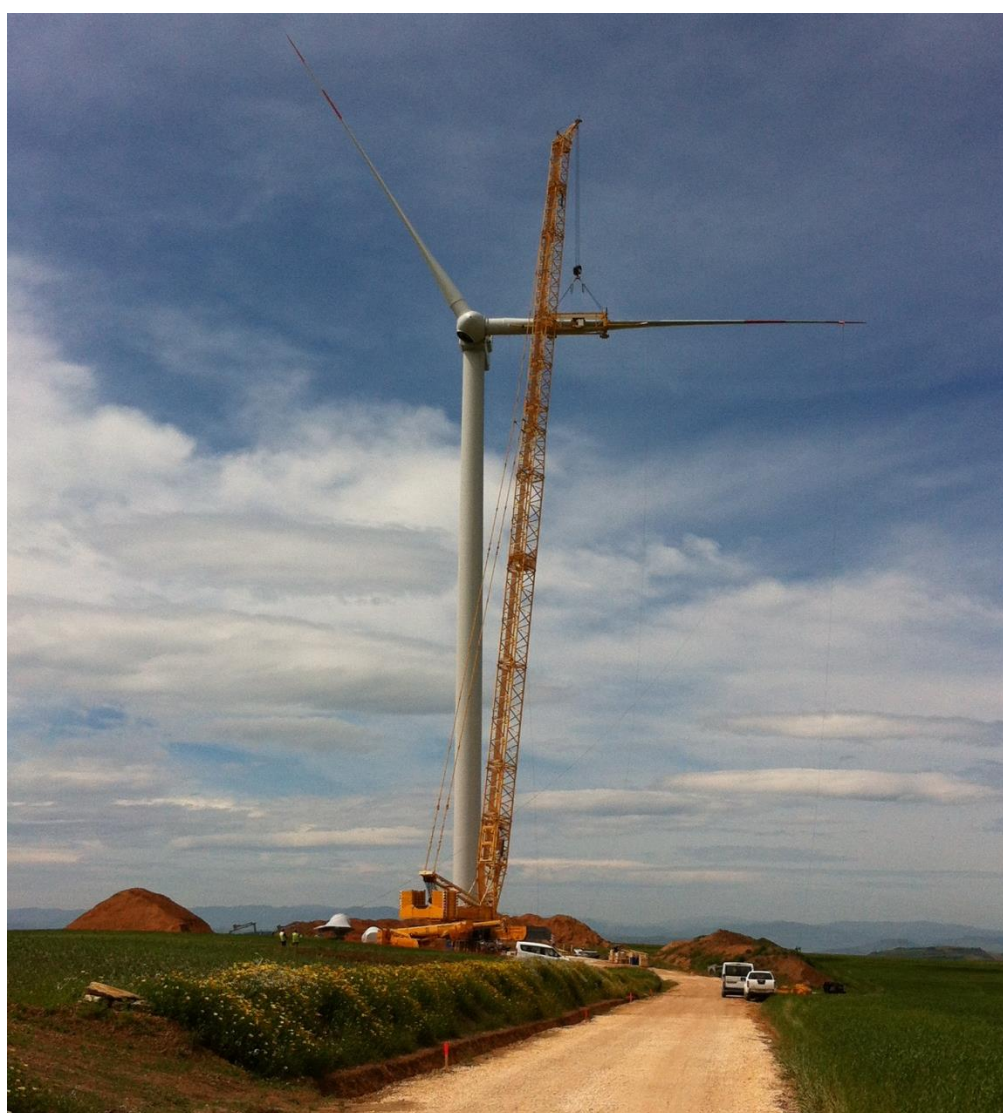
Fig. 2.10 - Montaggio aerogeneratore
