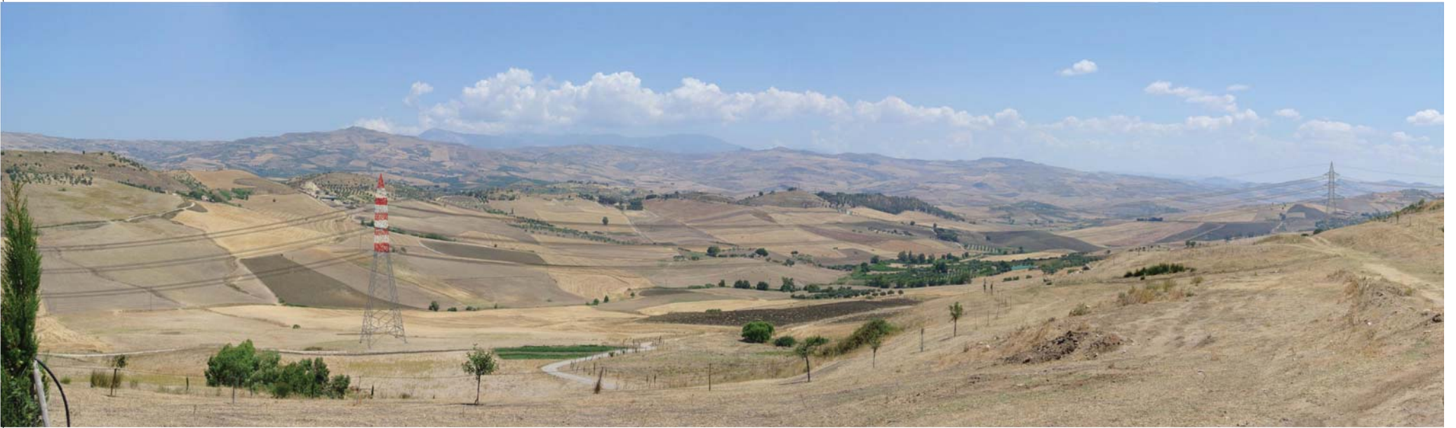
FOTOSIMULAZIONI PUNTO VISUALE PV. 3 Dir NORD EST - VARIANTE Tipologia sostegni utilizzati: TRALICCIO
