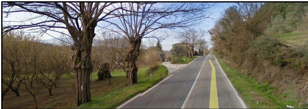
Figura 4.2.9c S.S. n.6 via Casilina
