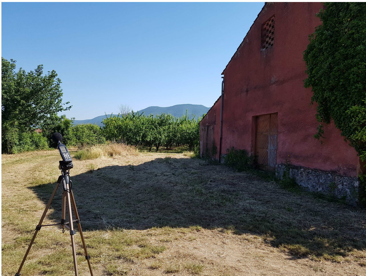
Figura 1 Foto postazione di misura P1
